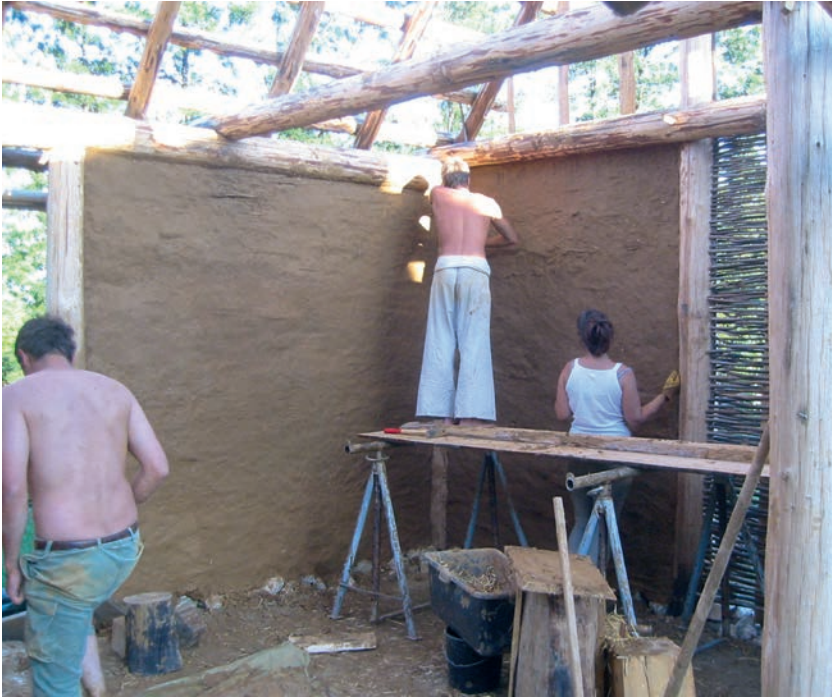
Abb. 102: Errichtung eines Pfostenbaus mit Flechtwerkwänden und Lehmbewurf im keltischen Freilichtmuseum von Schwarzenbach (Niederösterreich). Die Person im Vordergrund ist mit Lehmstampfen beschäftigt, während die beiden anderen den Lehmverputz auftragen (Eröffnung des Museums 2005; Foto: V. Reiter, Veröffentlichung mit freundlicher Genehmigung von V. Reiter).
