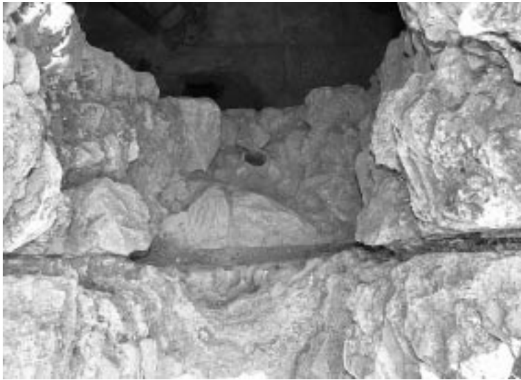
3 Ephesos, sog. İsa Bey Hamamı. Baufuge im Bereich des späteren Mauerwerksausbruchs
