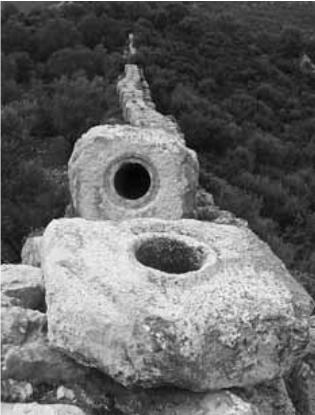
Abb. 23 Druckröhre von Norden in Fließrichtung
