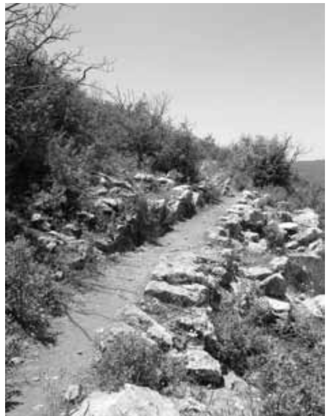
Abb. 26 Wasserleitungstrasse zwischen Firnaz und Delikkemer
