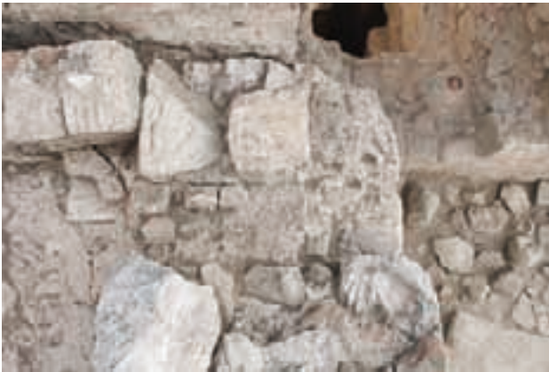
Abb. 5: Mörtelbettung eines Wasserrohres mit einem Rohrfragment auf der Krone der Südmauer des Raumes 12
