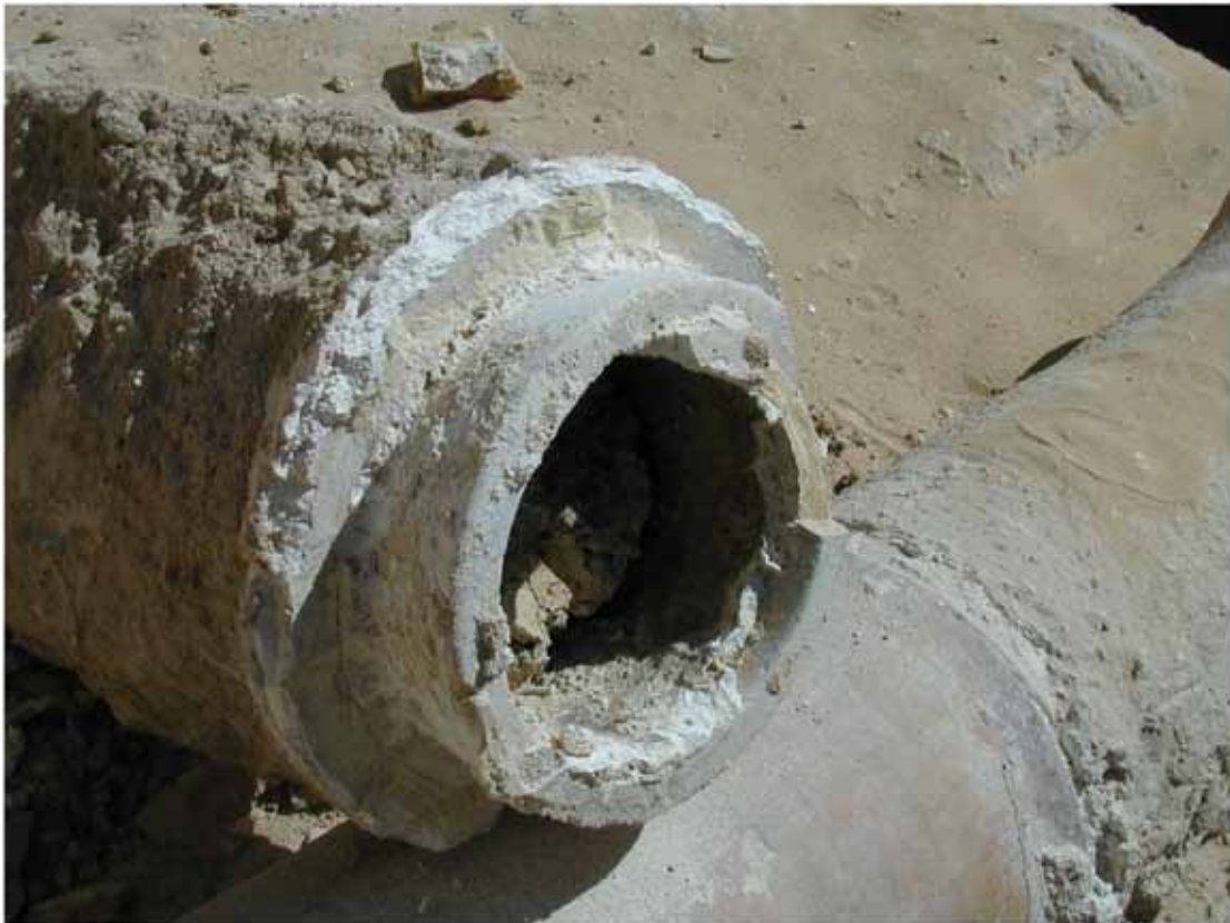
Abb. 9: Tonrohrsegment der hellenistischen Wasserleitung
