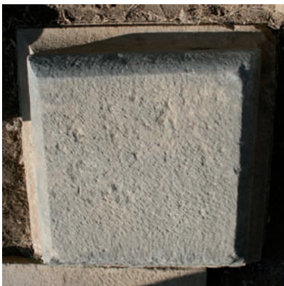
2 Vorhalle. Sockel Ehrenbasis SK 15
