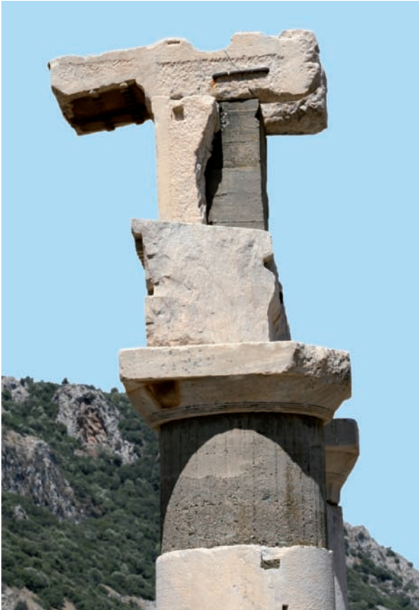
1 Vorhalle. Dorisches Gebälk von Osten
