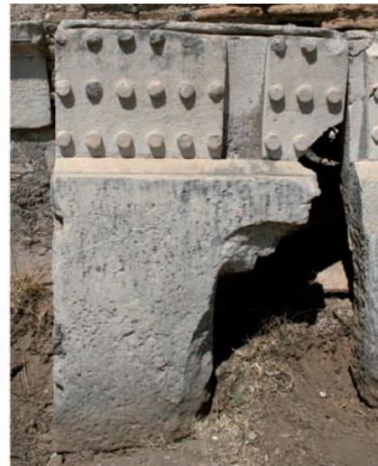
2 Vorhalle. Horizontalgeison A 10
