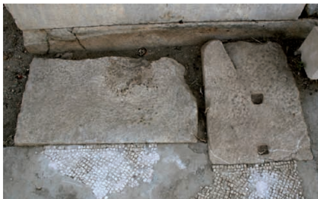
4 Vorhalle. Marmorplatten östlich von Tür 3
