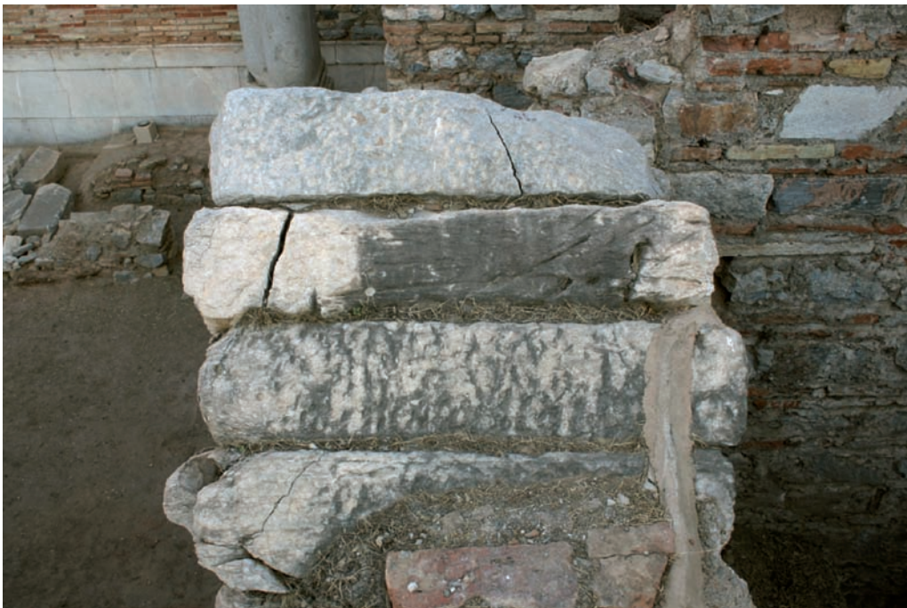
2 ›Hestiasaal‹. Nordwand. Keilsteinbogen Draufsicht
