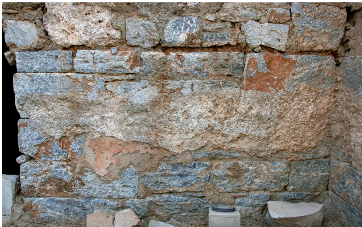
2 Raum 6. Nordwand. Detail Wandmalerei
