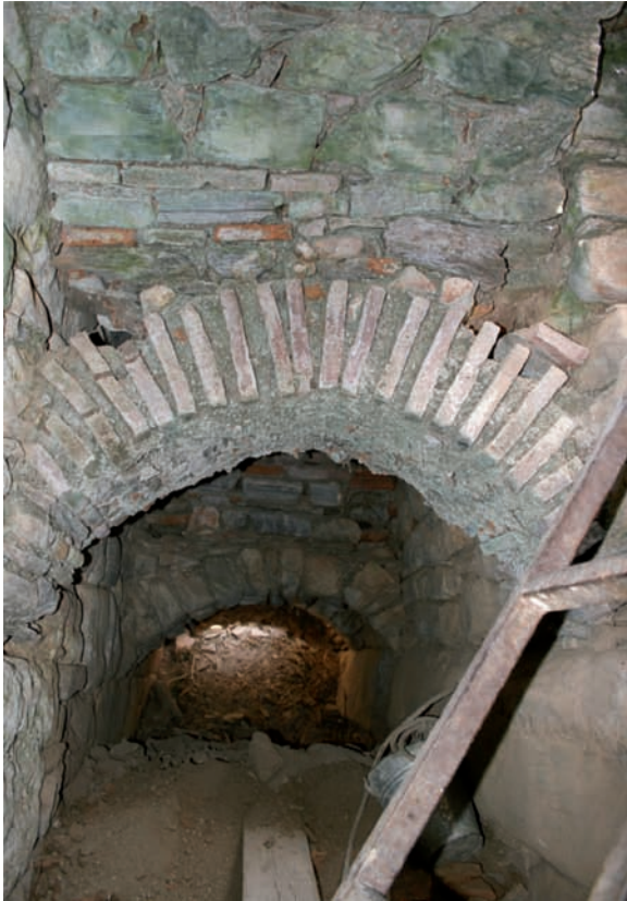
1 Kanal nördlich der Räume 5, 4, 3, 2
