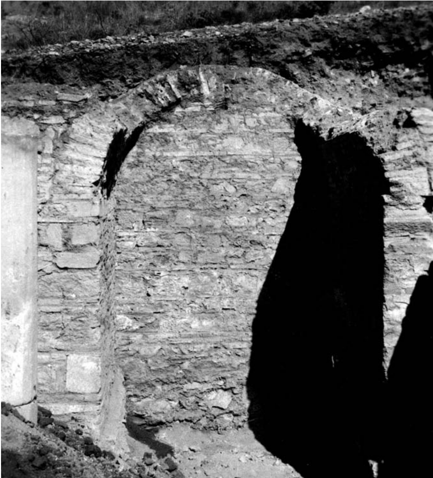
2 Raum 5. Gewölbe vor Absturz der Ostwand
