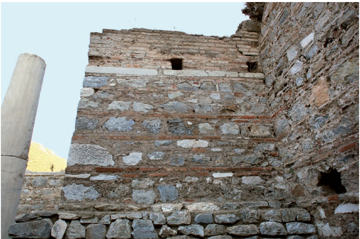
2 Raum 5. Sekundäre Nord-Süd-Mauer von Osten
