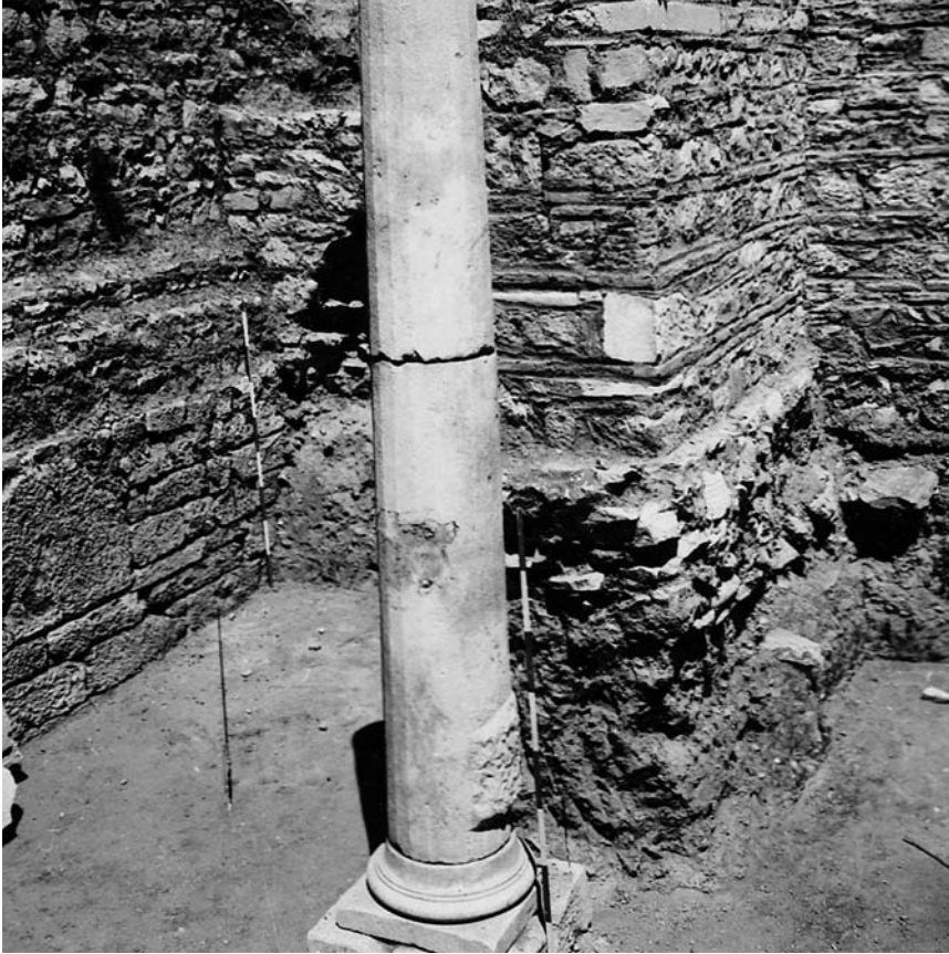
1 Raum 5. Sekundäre Nord-Süd- Mauer vor Sicherung
