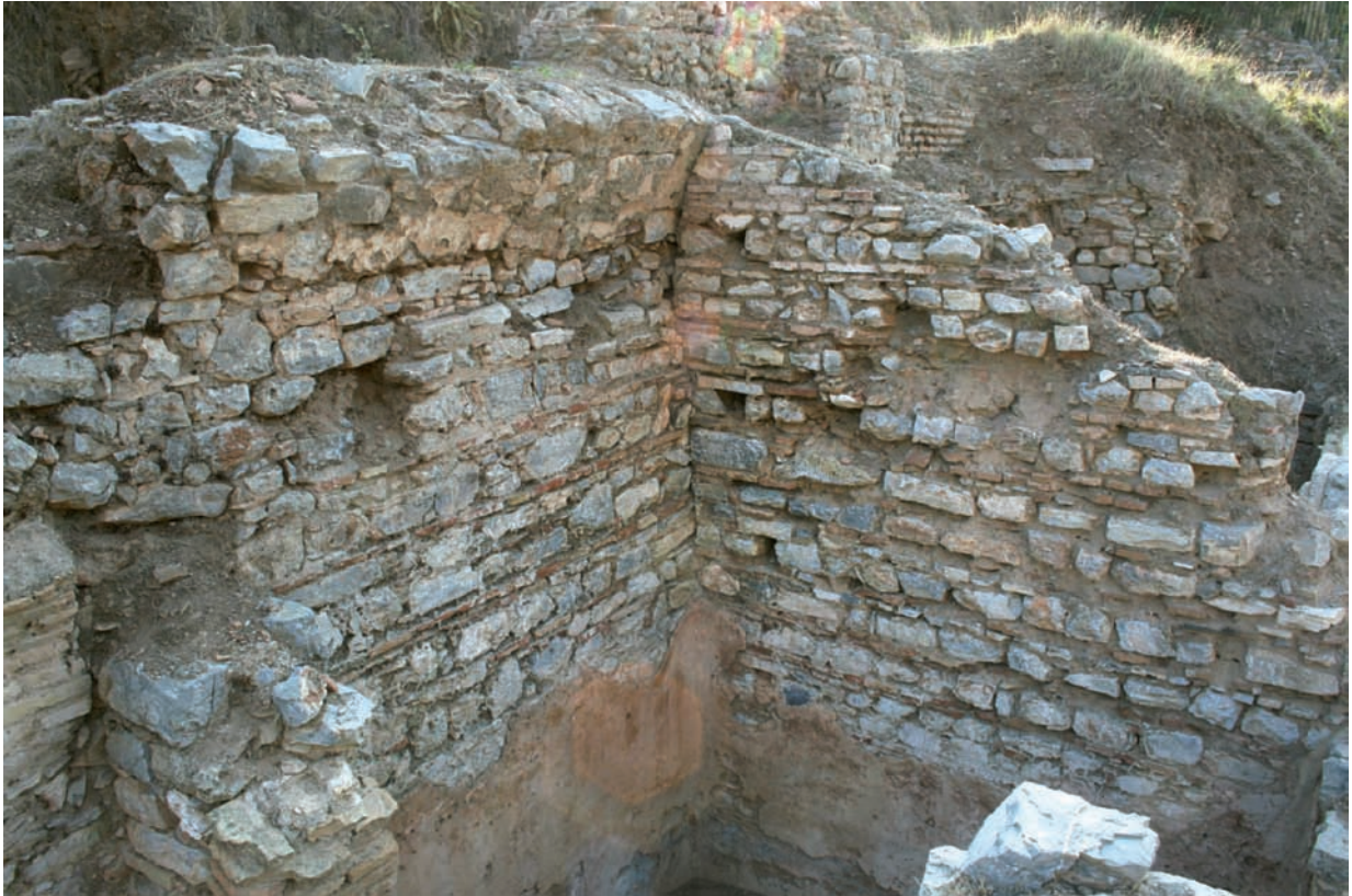
1 Raum 3. Nordwand oberer Teil
