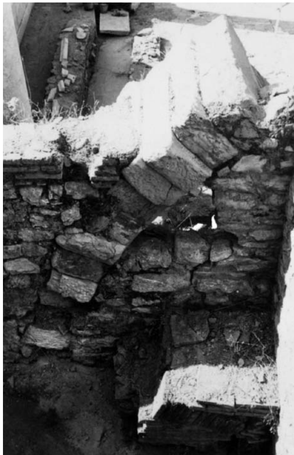
2 Raum 2. Ende der 1960er Jahre bereits weitgehend zerstörter Ziegelbogen
