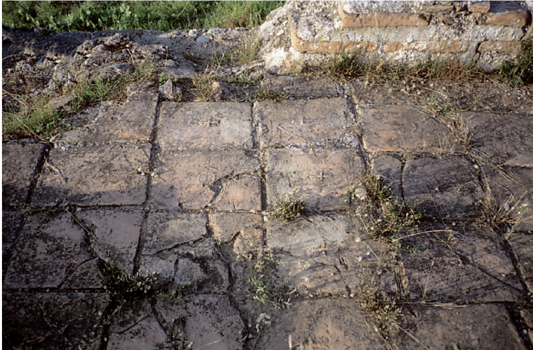
Abb. 18: Detailaufnahme des Ziegelplattenbodens
