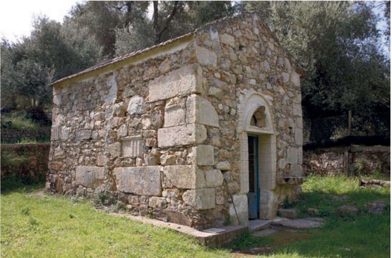
Abb. 1: Kakodiki, Panagia-Kirche (1331/2). Blick auf die Südostseite
