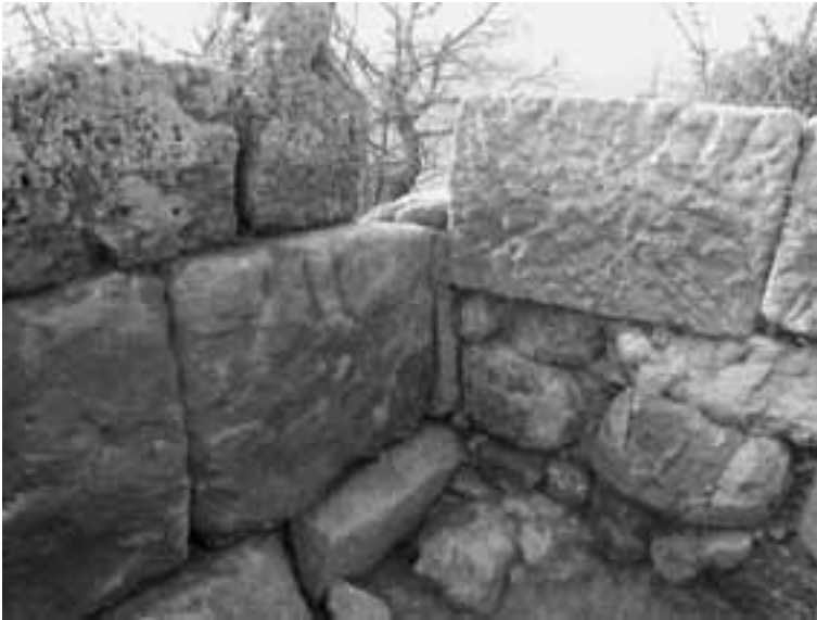
19 Terrasse I West, Schnitt 7/04: Blick auf die Nordwestecke. Links die großen Sandsteinquader UMA 78 des älteren Heiligtums, auf ihnen ein Konglomeratquader von UMA 18, rechts im Bild die Stadtmauer UMA 17 mit tiefer Fundamentierung
