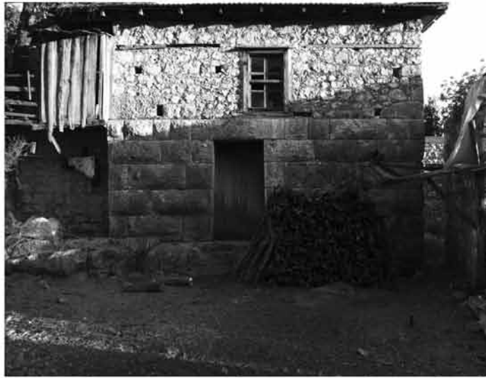
Abb.1: Spätklassischer Quaderbau in der Gegend von Sura/Lykien mit einem Aufbau zu Wohnzwecken aus dem späten 19. Jh.
