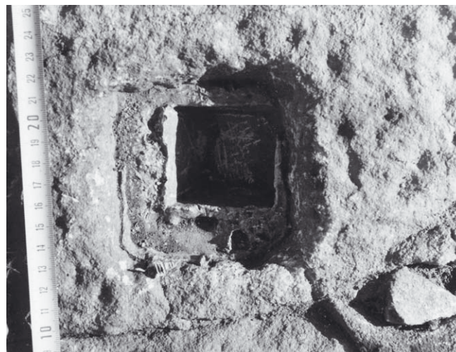
Abb. 89: Kantendübelloch mit Bleifüllung und Abdruck des quadratischen Dübels
