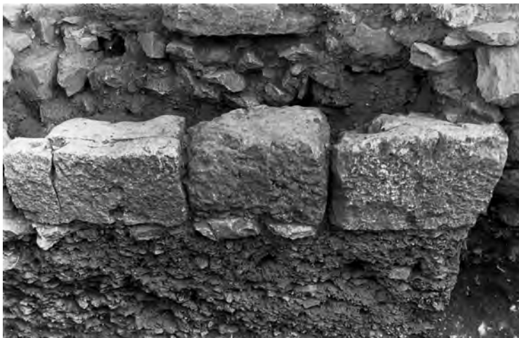
Abb. 40 b Kuretenhalle, Grabungsfläche 3: Mauer G
