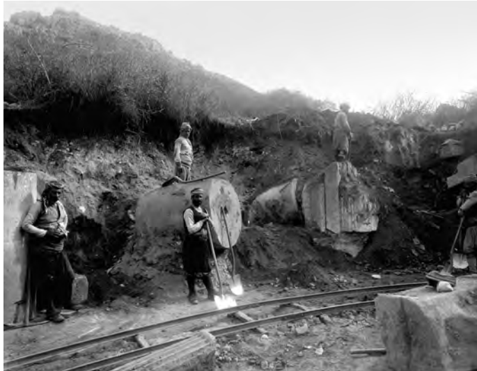
Abb. 29 Die Kuretenhalle mit den Säulentrommeln aus dem Prytaneion bei der Freilegung 1904–1905
