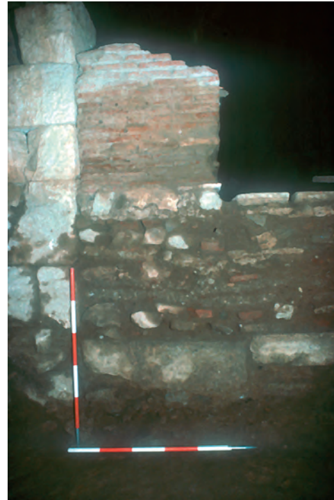
Abb. 21 Detail des sog. Quaderbaus mit spätantik zugesetzter Türöffnung
