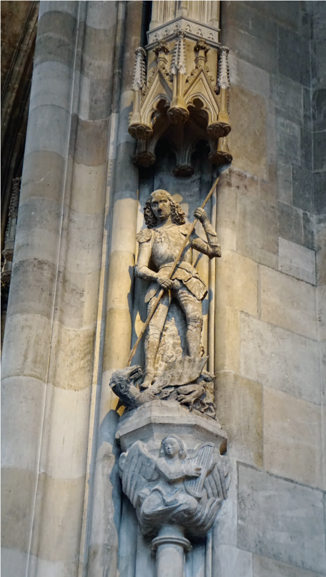
Abb. 1: Säulenfigur im Chor: hl. Georg, ursprünglich am Nordturm (Q07), Konsole von Franz Barwig jun.
