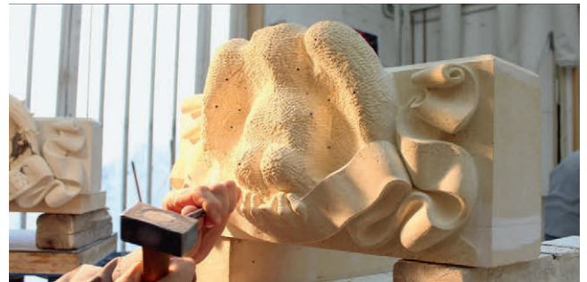
Abb. 7: Zerstörte Basis des hl. Johannes an der Bartholomäuskapelle, Aufmodellierung und Kopie in Sandstein
