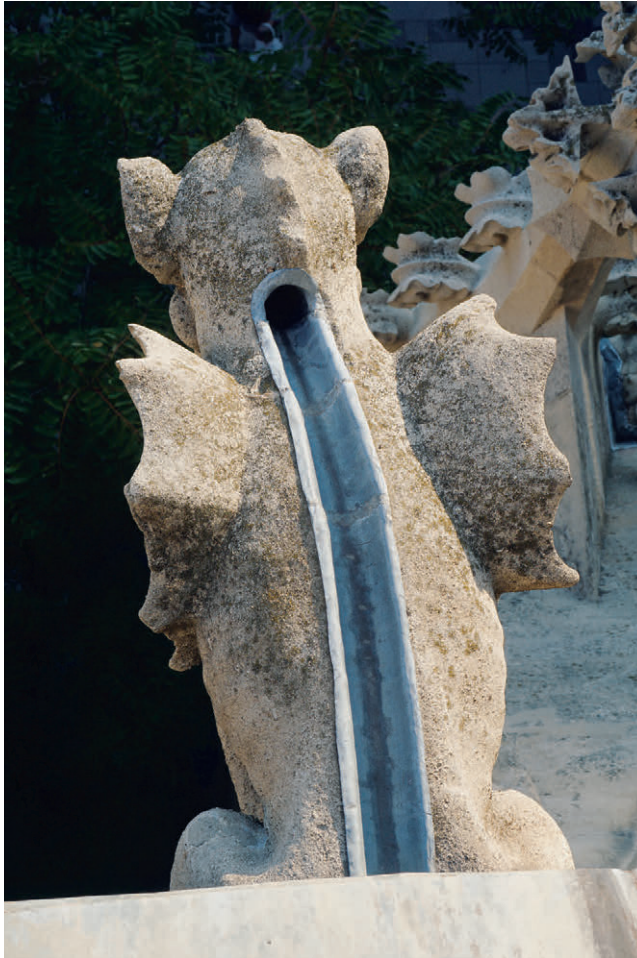
Abb. 6: Verbleites Gesims und Bleirinne an einem Wasserspeier
