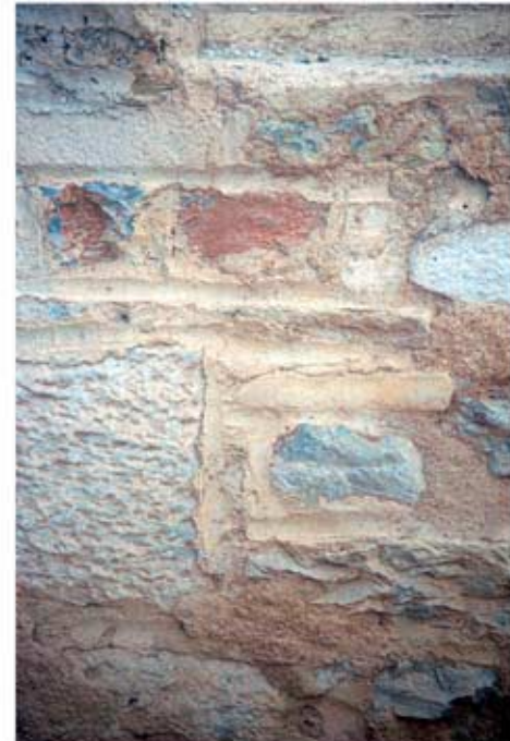
13.2: Quader-Bruchstein-Mauerwerk Typ 2 der Bauphase I: Raum 5, S-Wand
