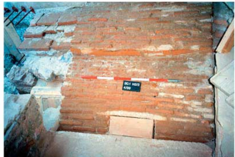
18.4: Raum 2, freigelegtes Gewölbe
