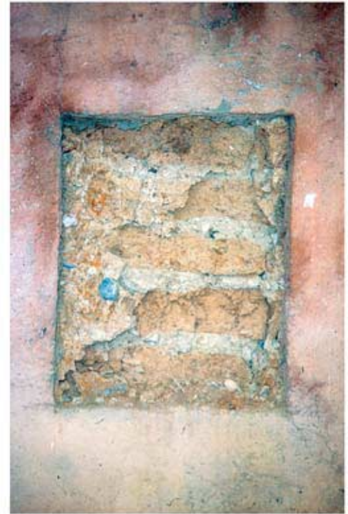
14.3: Lehmziegelmauerwerk (Typ 11): WE 2, Raum SR 19, S-Wand
