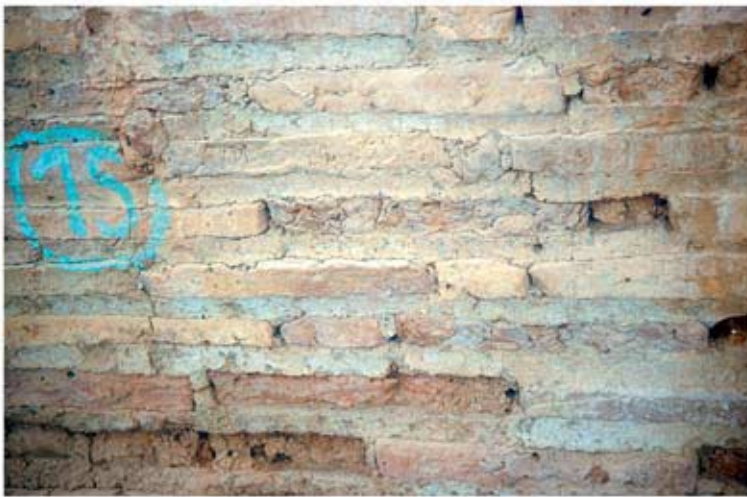
13.5: Ziegelmauerwerk b (Typ 7) der Bauphase II: Raum 15.1, S-Wand
