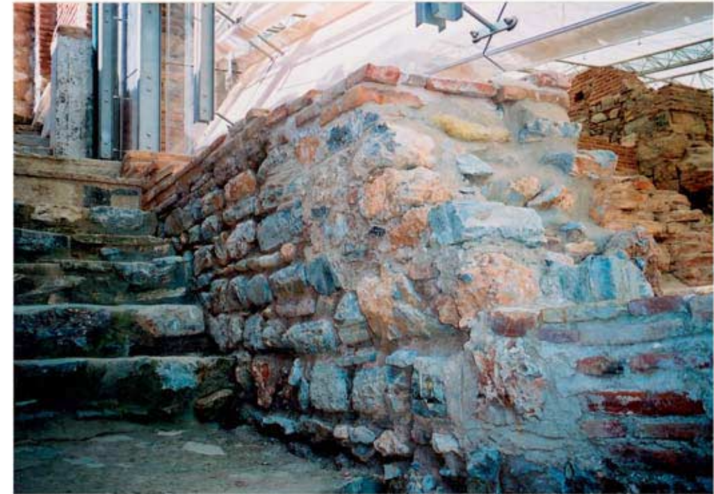
16.3: WE 4, Ansicht der Westfassade
