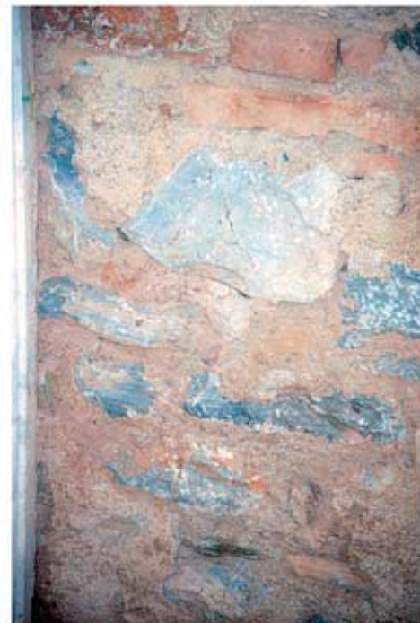
13.7: Bruchstein-Mauerwerk Typ 4 der Bauphase III: Raum 5, O-Wand, Türvermauerung
