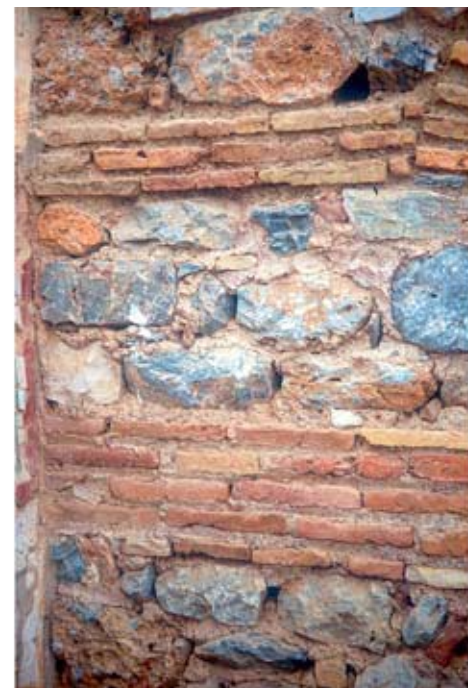
13.6: opus mixtum -Mauerwerk (Typ 5) der Bauphase III: Raum 7, W-Wand
