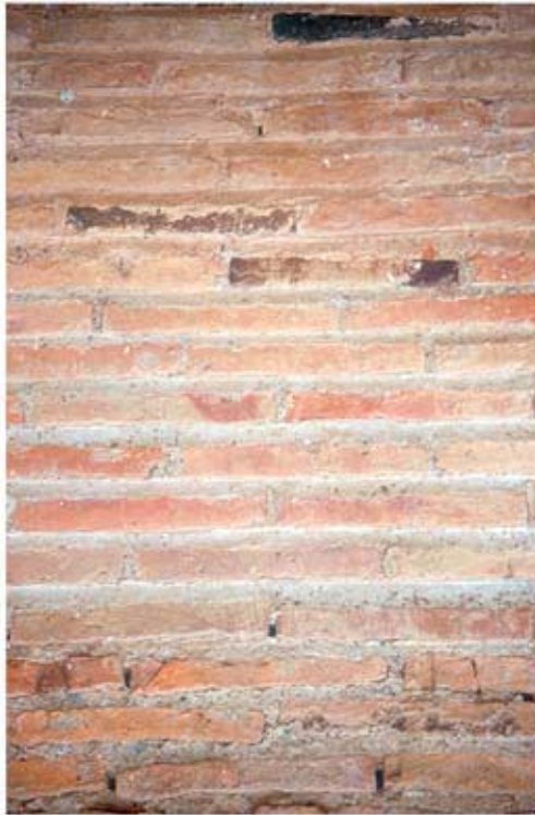
14.1: Ziegelmauerwerk c (Typ 8) der Bauphase III: Raum 7, S-Wand
