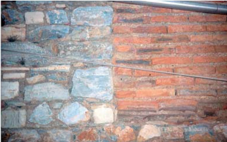
13.3: Ziegelmauerwerk a (Typ 6) der Bauphase I: WE 6, Peristylhof 31a, O-Wand
