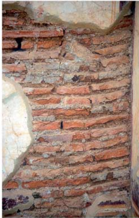
14.2: Ziegelmauerwerk e (Typ 10) der Bauphase IV': Hof 21, S-Wand
