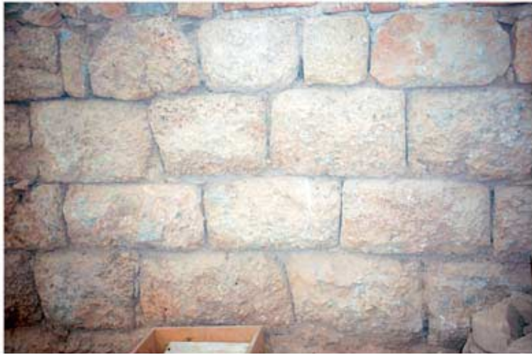
13.1: Quader-Mauerwerk Typ 1 der hellenistischen Vorbebauung: Räume SR 9, Südterrassenmauer
