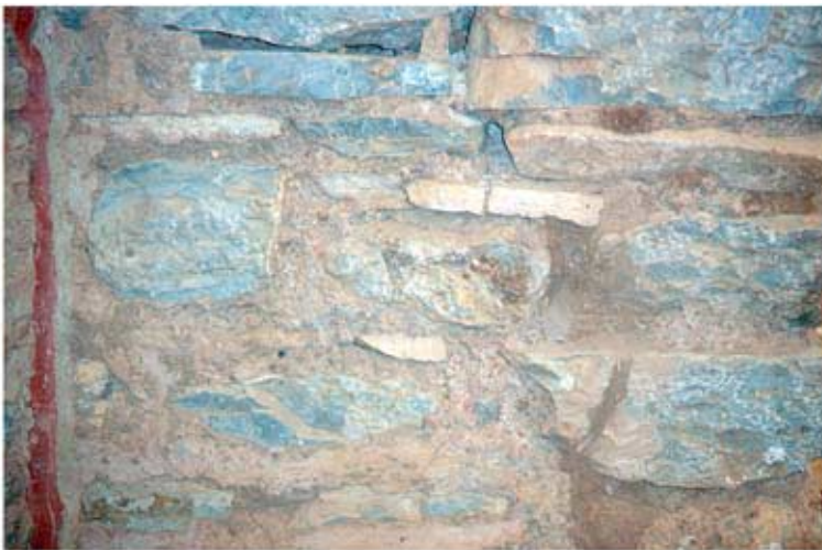
13.4: Bruchstein-Mauerwerk Typ 3 der Bauphase II: Raum 7, N-Wand
