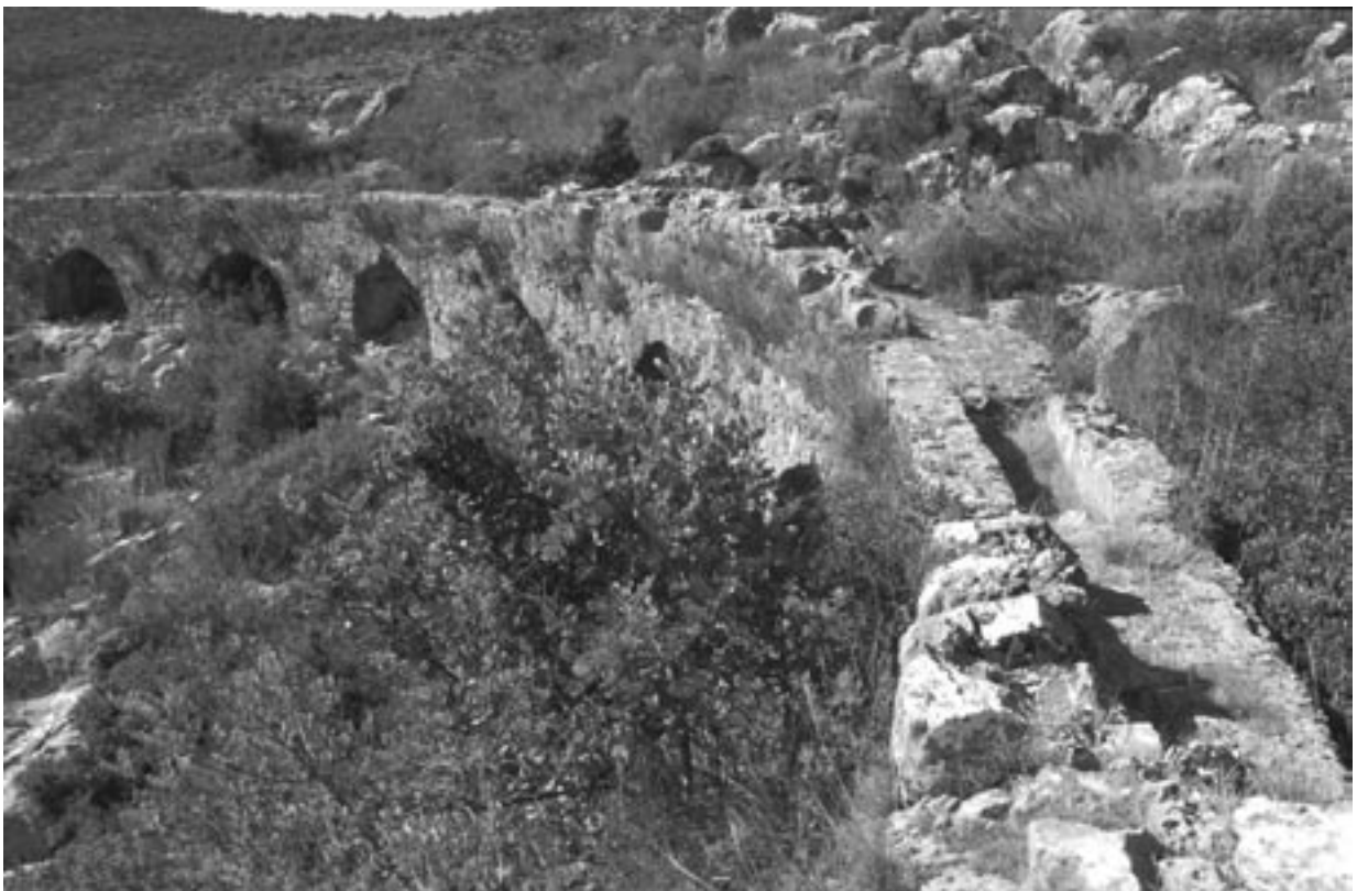
18 Andriakē/Çalpat Limanı, Aquäduktleitung zur Wassermühle
