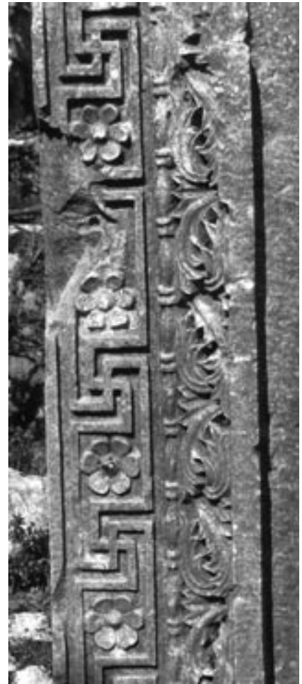
4 Akalissos/Asarcık West, Johanneskloster: Türwange, Eingang südliches Seitenschiff
