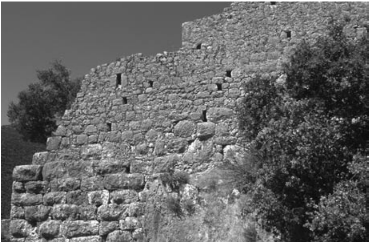
22 Aperlai/Sıcakiskelesi, hellenistische und spätrömische/frühbyzantinische Ostmauer mit Rüstlöchern
