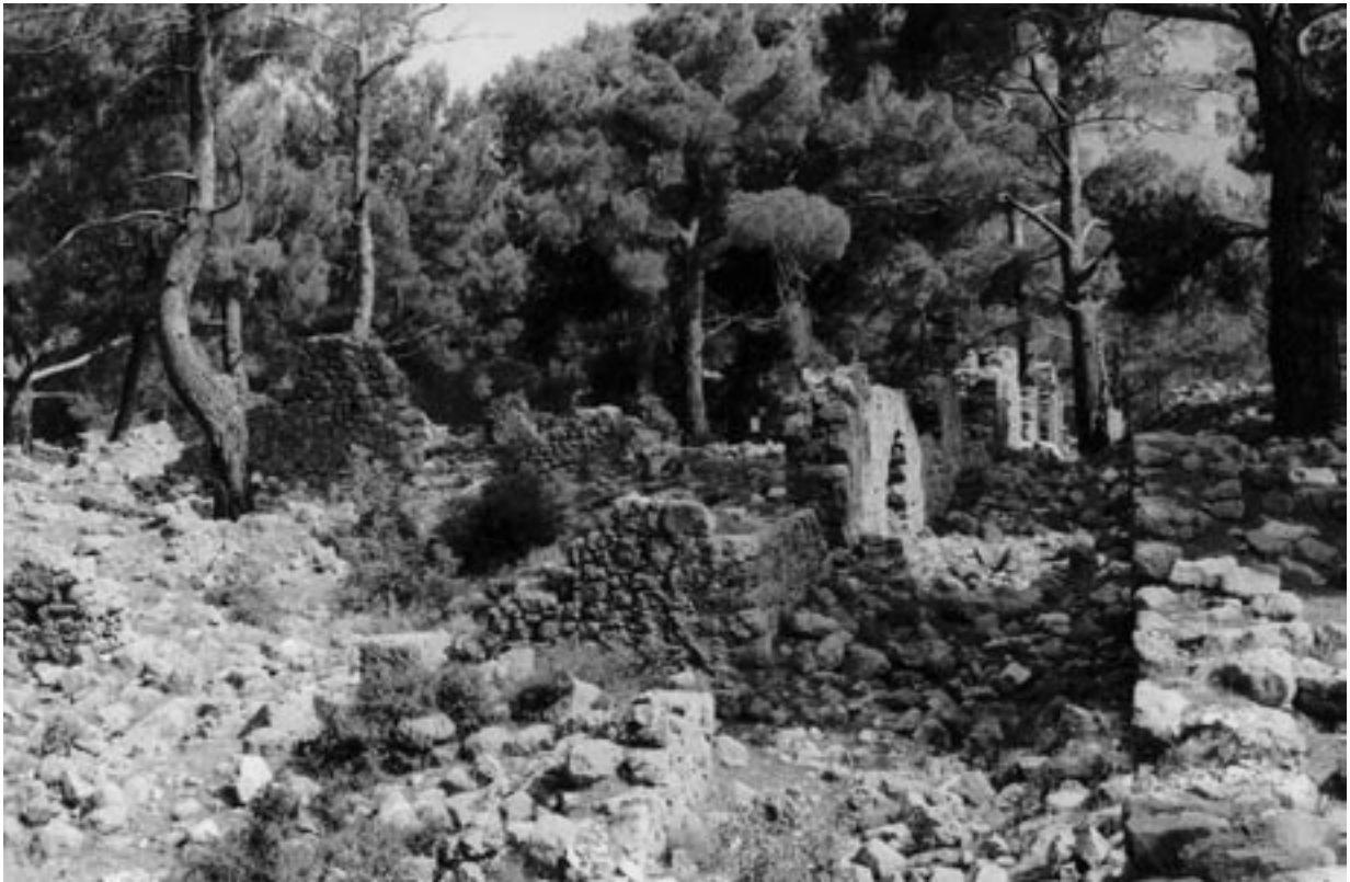
35 Arif, frühbyzantinischer Straßenzug mit Hausfronten
