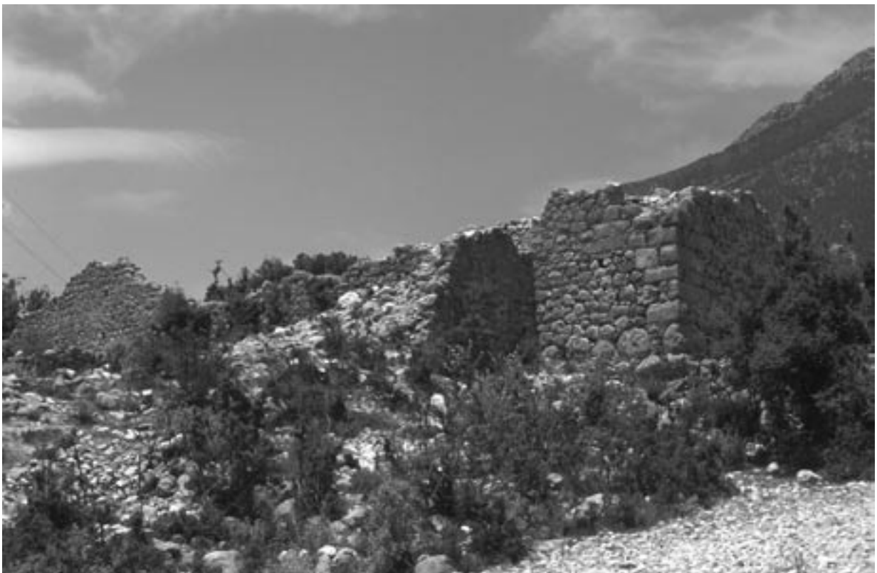
32 Arif, Wehrmauer von Südosten
