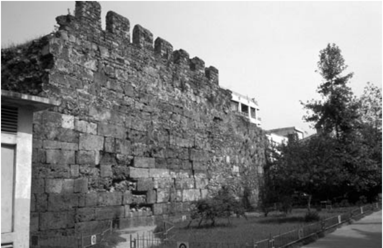
63 Attaleia/Antalya, Atatürk Bulvarı, spätrömisch-byzantinische Wehrmauer, Ostseite der Stadt
