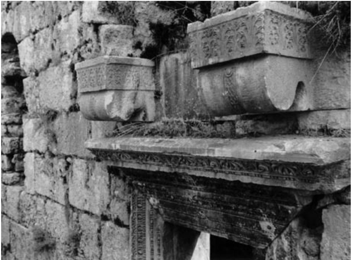
69 Attaleia/Antalya, Kesik Minare, römischer Türsturz der Südtüre und Konsolen mit frühbyzantinischen Ornamenten
