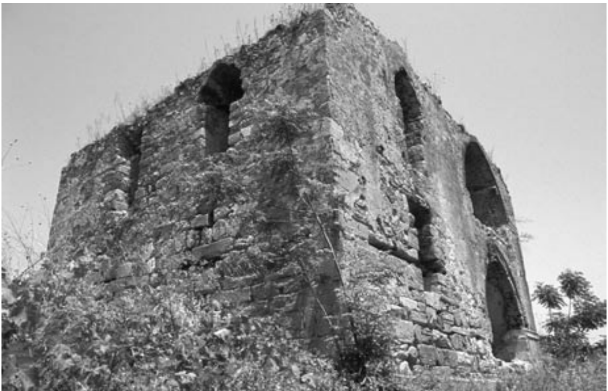
98 Demirtaş, seldschukischer Köşk am Sedre Çayı, von Südosten
