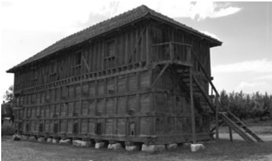
85 Bayralar, Holzspeicher des frühen 20. Jahrhunderts auf kaiserzeitlichen Spolien
