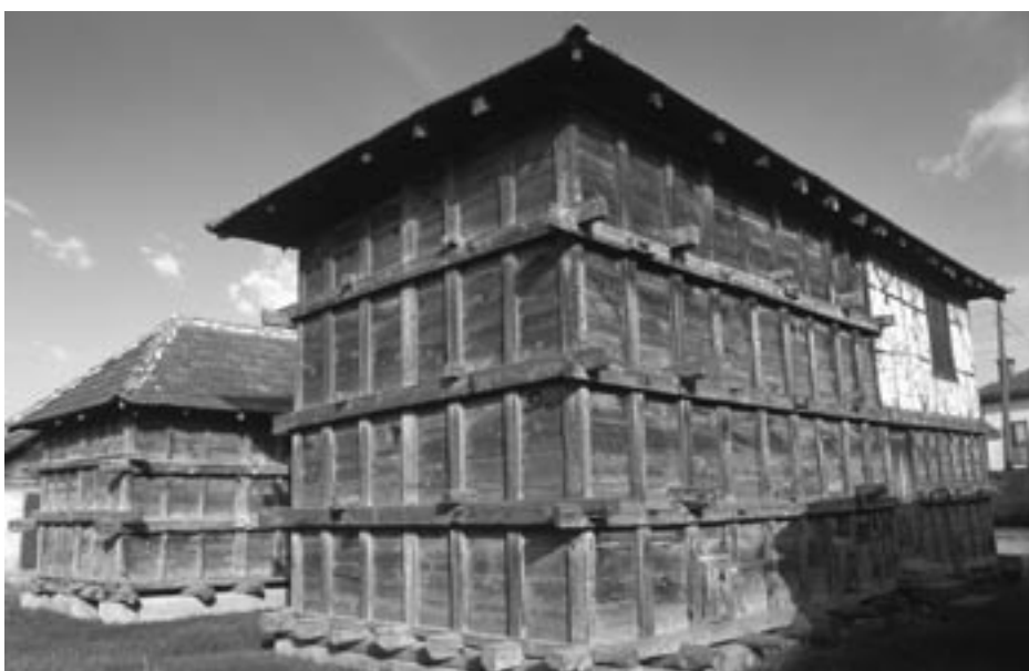
86 Beyler, Holzspeicher des frühen 20. Jahrhunderts
