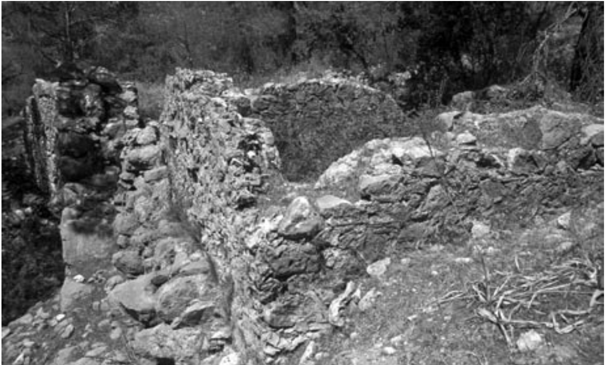
110 Gagai/Mavikent (Yeniceköy), Flur Aktaşharabeleri, frühbyzantinische Stadtmauer mit frühbyzantinischem Haus
