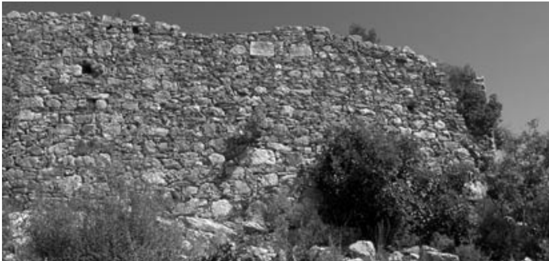
122 Hamaxia/Sinekkalesi, spätrömisch/frühbyzantinische Wehrmauer im Süden
