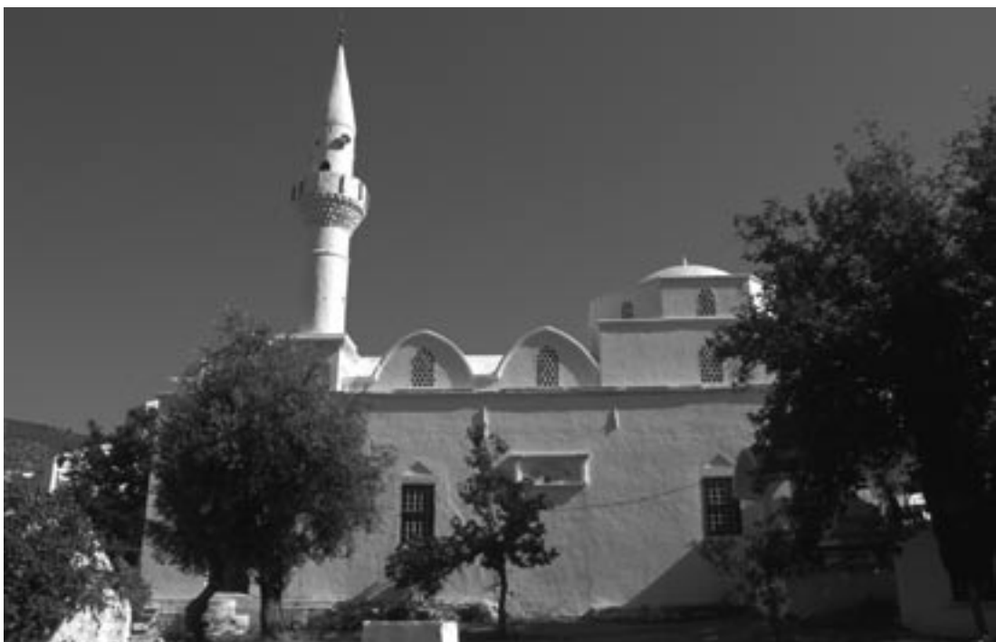
144 Kalamina/Kalkan, Eisodia Theotoku, Hallenkirche der zweiten Hälfte des 19. Jahrhunderts, umgebaut zur Moschee
