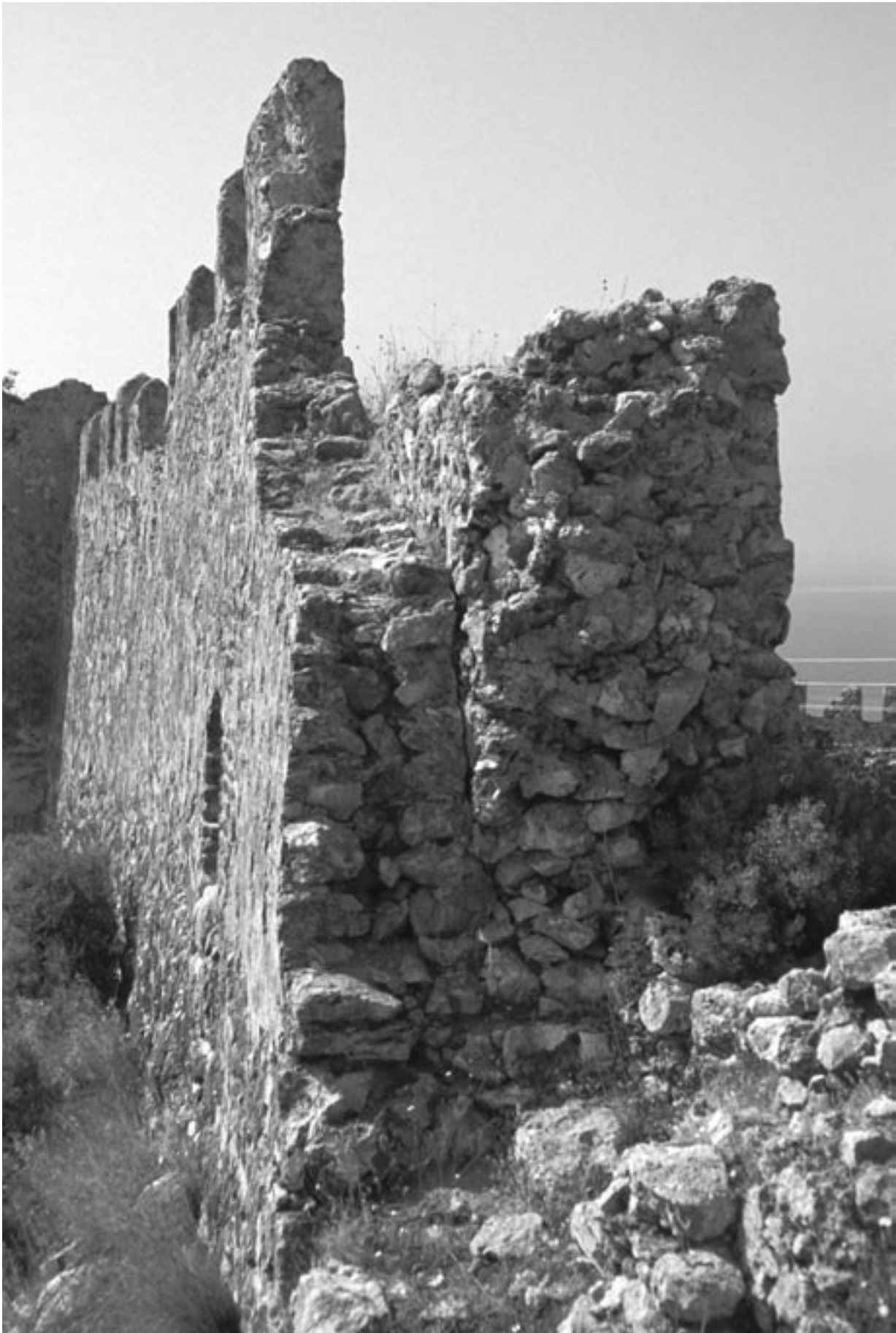
145 Kalon Oros/Burg von Alanya, Ortakale, Ostseite, mittelbyzantinische Wehrmauer mit seldschukischer Innenverstärkung
