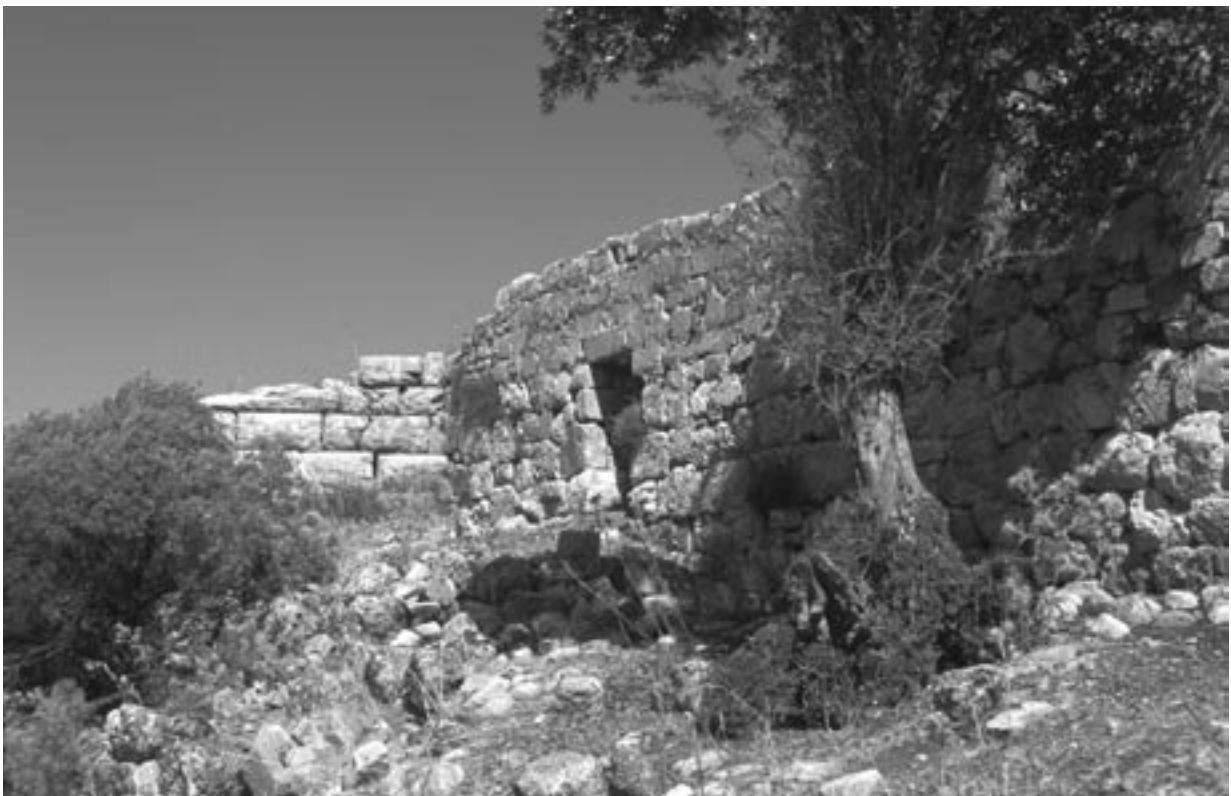
153 Kalynda/Kozpınar östlich von Şerefler, frühbyzantinische Wehrmauer, im Hintergrund hellenistische Quadermauer
