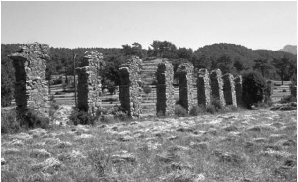
186 Kemer 2, Aquädukt zum befestigten frühbyzantinischen Gehöft
