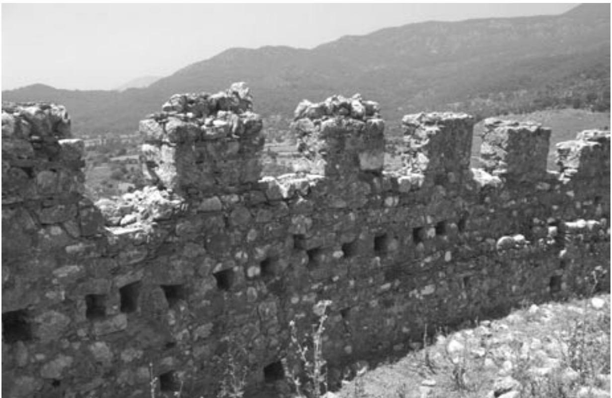
182 Kaunos, mittelbyzantinisches Kastron, Innenseite der Wehrmauer
