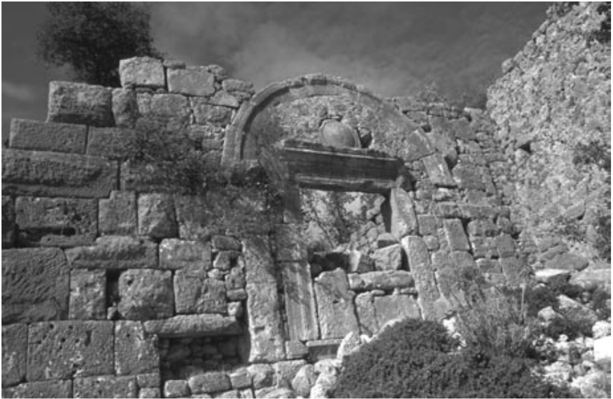
204 Kyaneai, frühbyzantinische Stadtmauer, Westtor, Vermauerung in mittelbyzantinischer Zeit (?)
