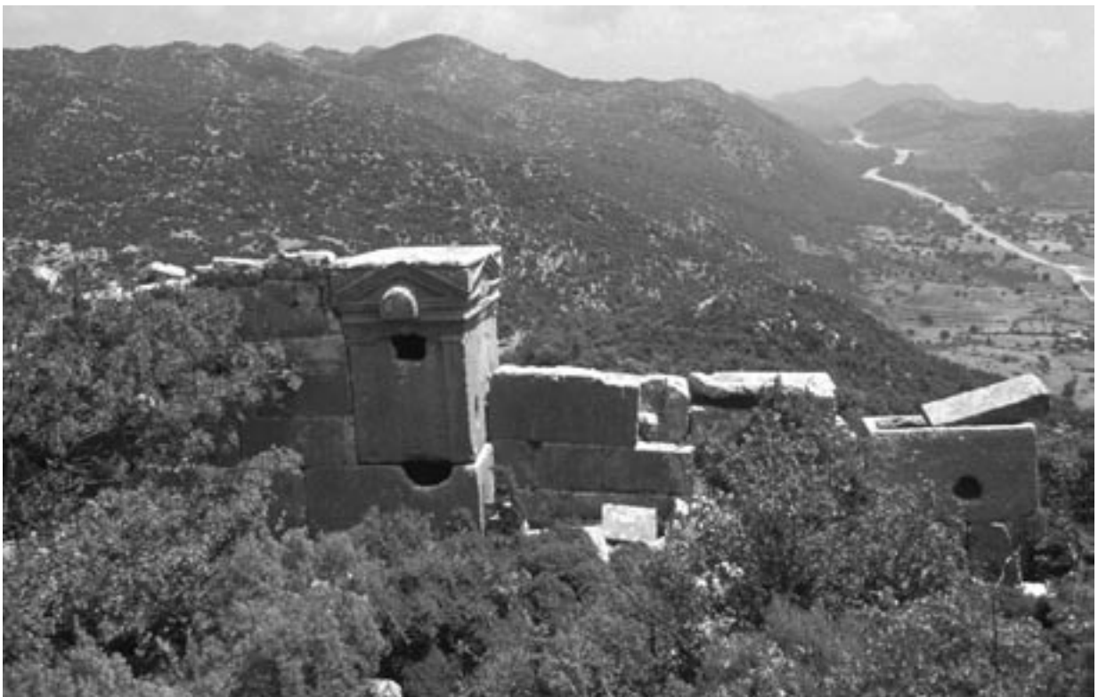
205 Kyaneai, frühbyzantinische Stadtmauer im Nordosten, mit römischen Sarkophagen als Spolien, Blick ins östliche Yavu-Tal
