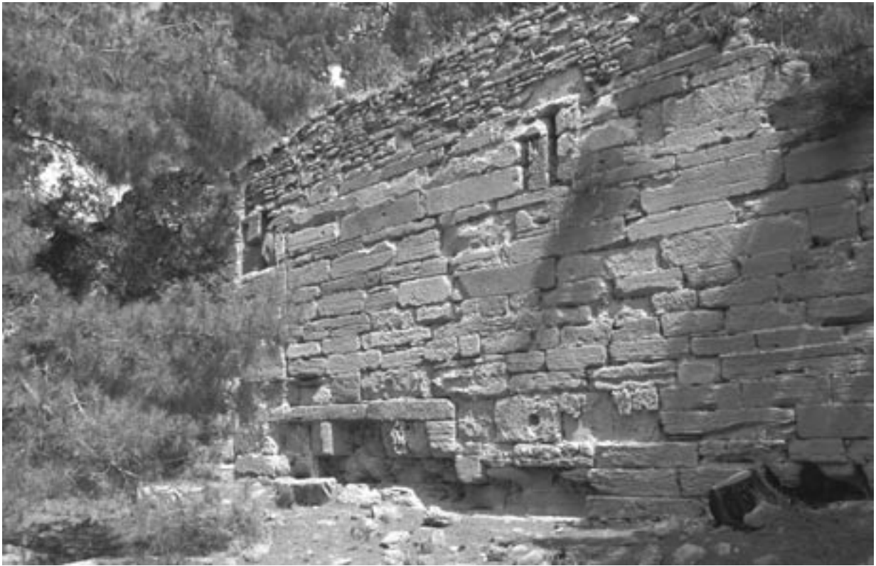
227 Lyrbē/Hisar bei Şihlar, spätrömische Stadtmauer im Süden
