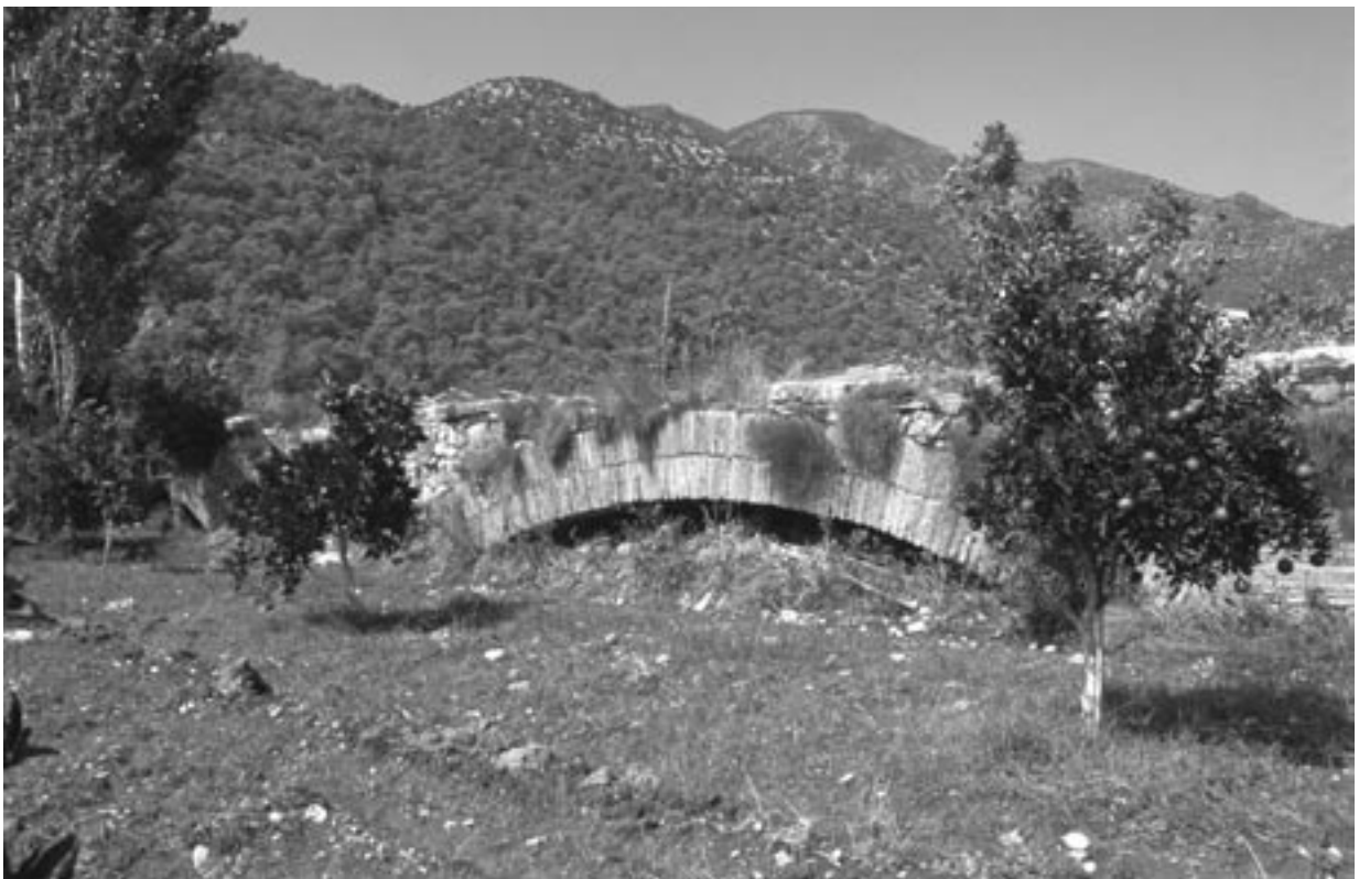
217 Limyra/Yuvahılar Köy, frühbyzantinischer Brückenbogen der Kırk göz kemeri-Brücke über das ehemalige Flussbett des Alakır Çayı
