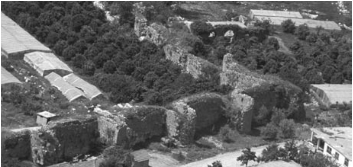
220 Limyra/Yuvalılar Köy, Nordwestecke der byzantinischen Weststadt mit rechteckig vorspringenden Bastionen
