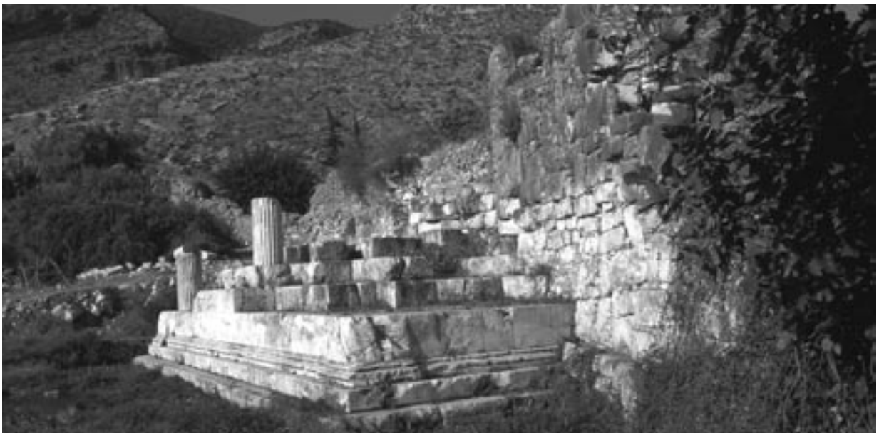
221 Limyra/Yuvalılar Köy, Weststadt, Überbauung des Ptolemaions mit frühbyzantinischer Ostmauer (Innenseite)
