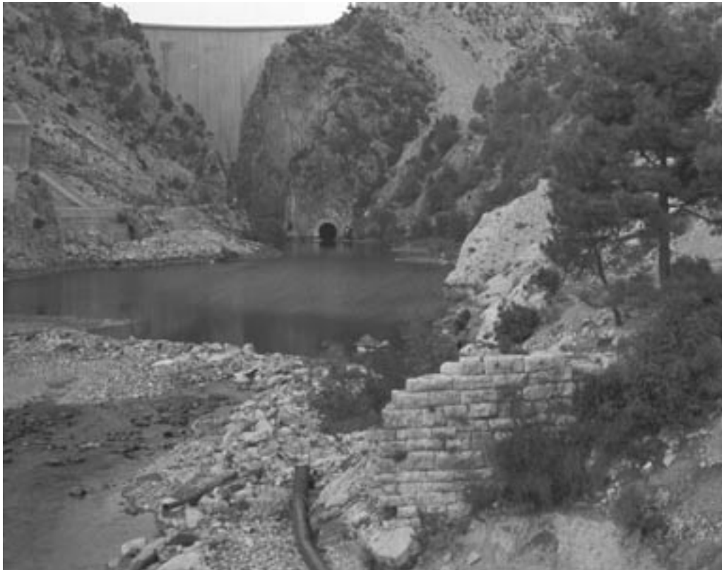
248 Römische Brückenrampe am Ostufer des Melas/Manavgat Çayı unterhalb der Oymapınar Barajı
