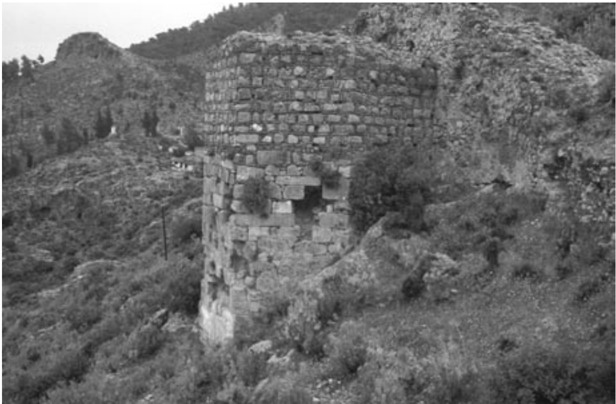
237 Makrē/Telmēssos/Fethiye, mittelbyzantinische Bastion mit Kästelwerk, komnenische Zeit
