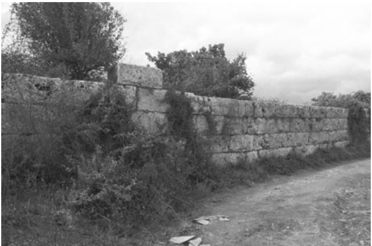
234 Römische Straße Magydos/Lara-Perge, römische Brückenrampe am Soğucaksu Deresi
