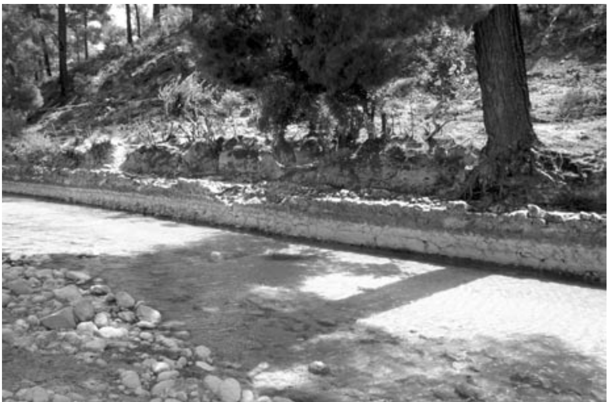
264 Myros-Tal/Demre Çayı, ausgebauter römisch/frühbyzantinischer Straßendamm
