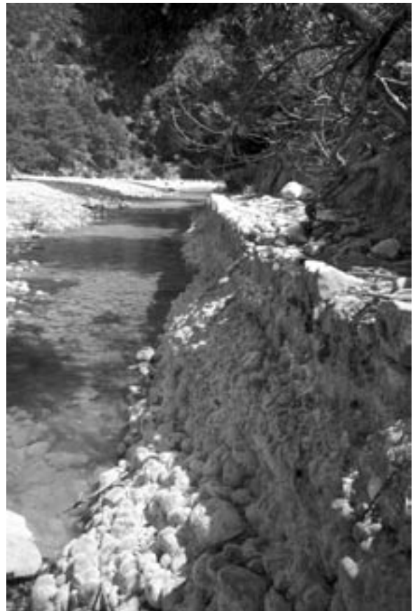
262 Myros-Tal/Demre Çayı, Unterbau der römisch/frühbyzantinischen Straße Myra–Dereağzı/ Mastaura
