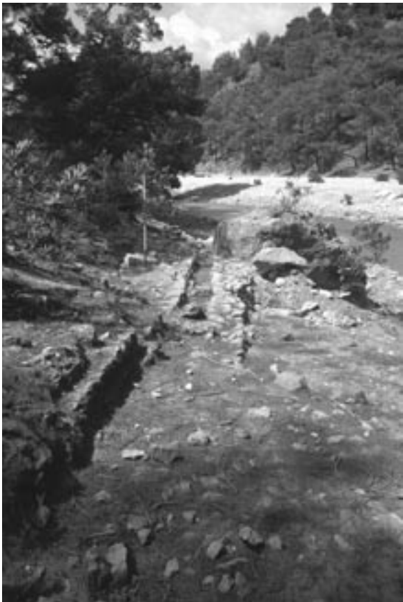
261 Myros-Tal/Demre Çayı, Kanalrinne der römischen Wasserleitung nach Myra
