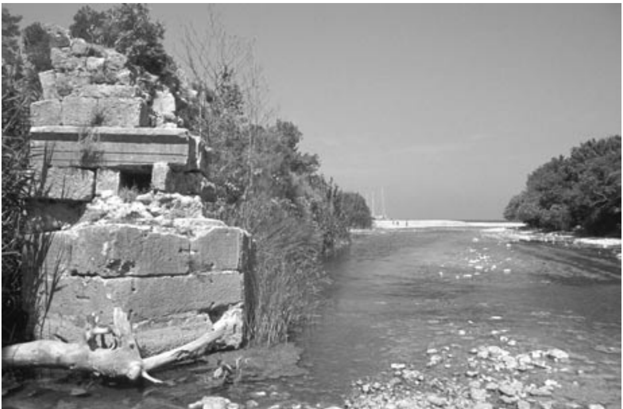
276 Olympos 1, frühbyzantinischer Brückenpfeiler aus römischen Spolien
