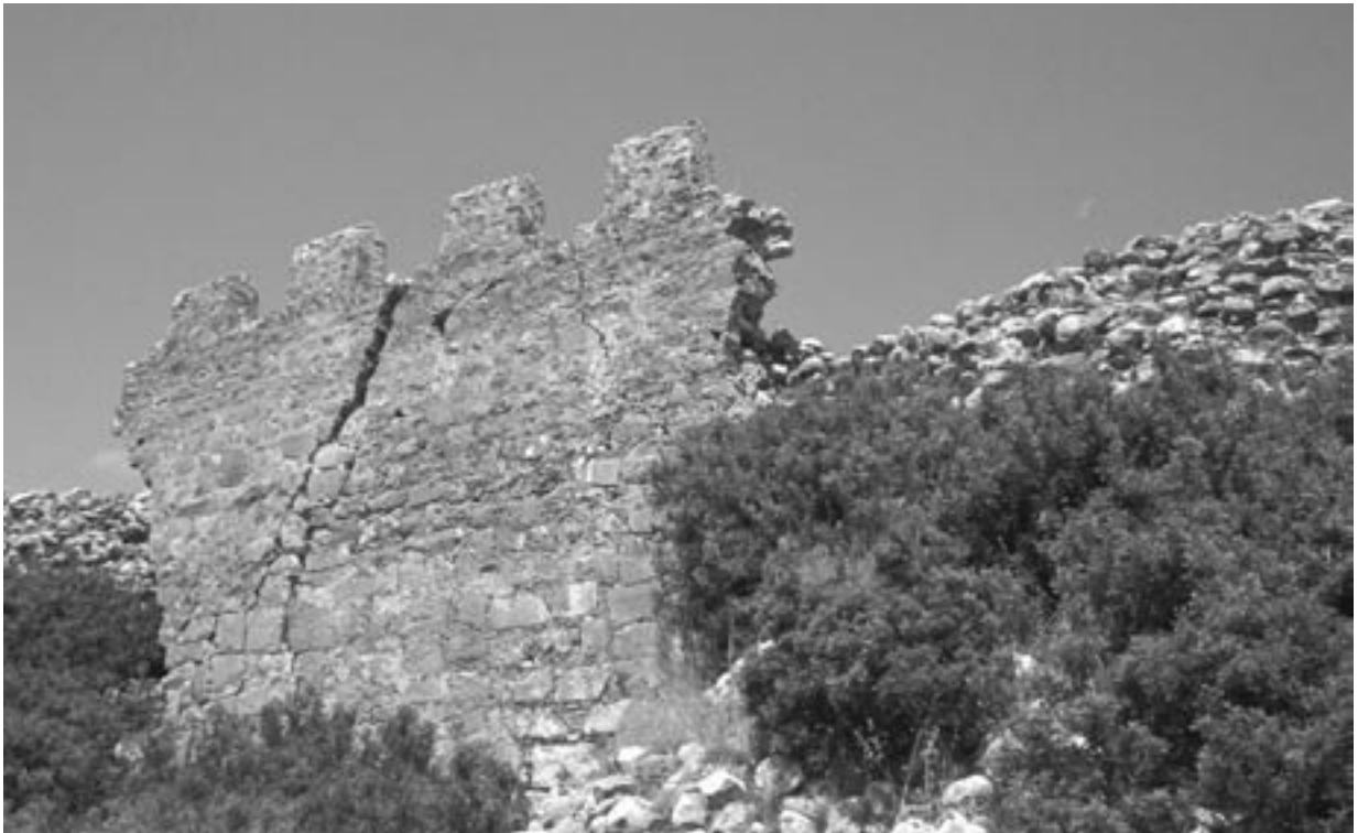
294 Patara/Kelemiş, mittelbyzantinische Mauer des Kastron
