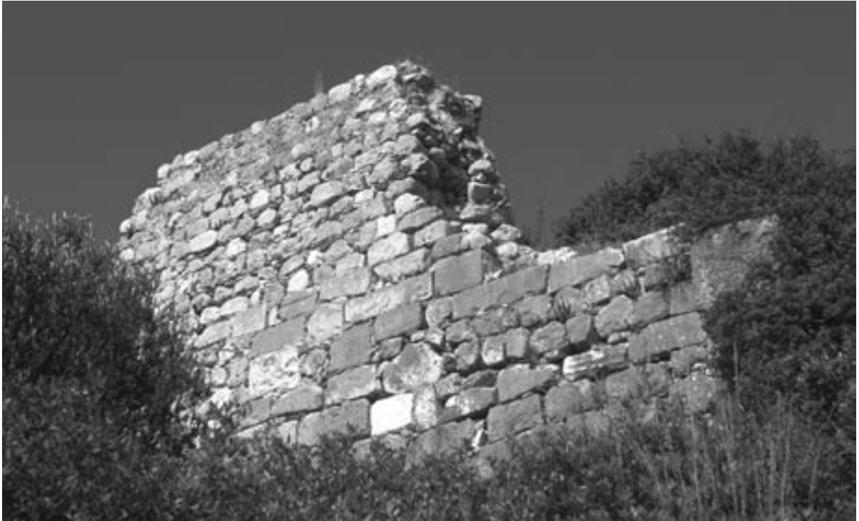
293 Patara/Kelemiş, mittelbyzantinische Mauer des Kastron
