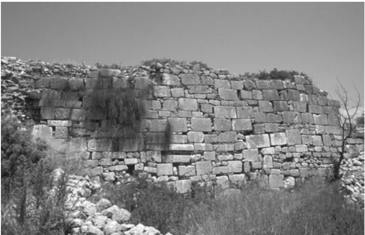
292 Patara/Kelemiş, frühbyzantinische Stadtmauer
