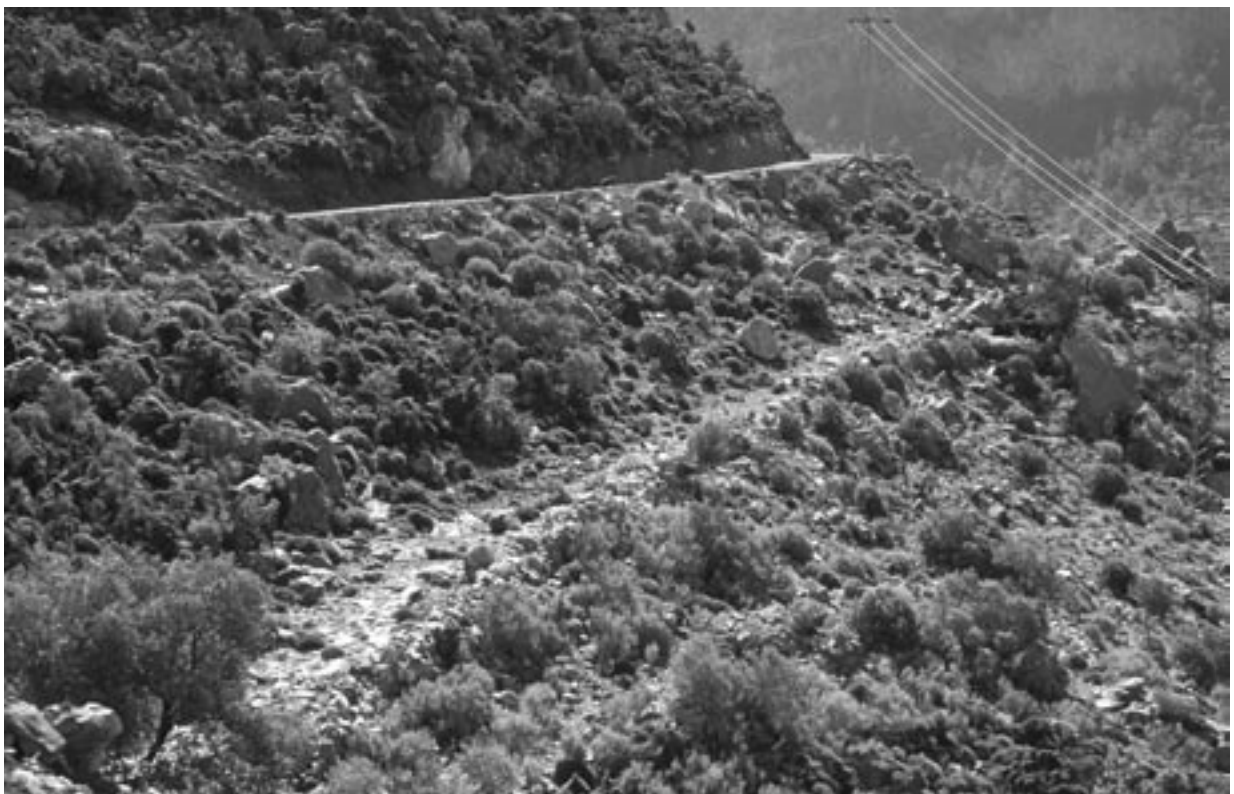
302 Perdikiaï/Faralya, untere Trasse: römisch/osmanische Küstenstraße zwischen Lebissos/Kaya und Sidyma/ Dodurga
