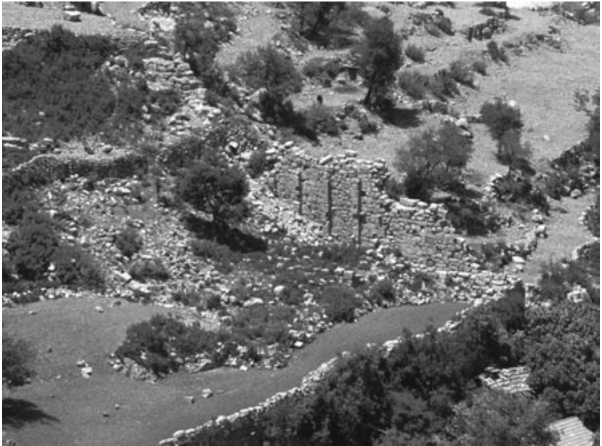
332 Selgē/Zerk, östliche frühbyzantinische Stadtmauer
