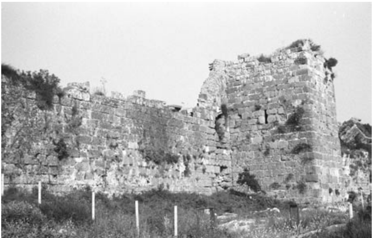
337 Sidē, Turm der spätrömisch-frühbyzantinischen Stadtmauer (Ostseite)
