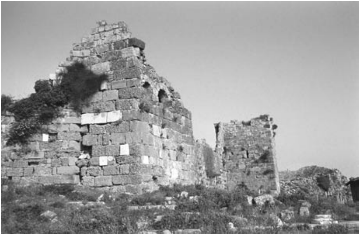
336 Sidē, Spätrömisch-frühbyzantinische Stadtmauer (Ostseite)
