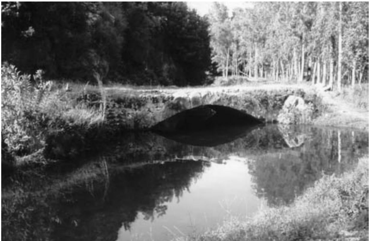
397 Tenedos/Antalya, Stadtflur Arapsuyu, römische Brücke
