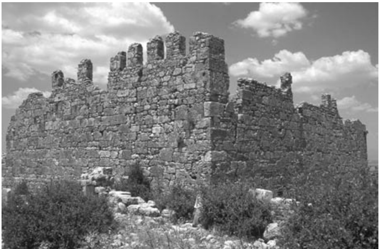
391 Syllaion/Kocahisar bei Yanköy, byzantinisches Kastion
