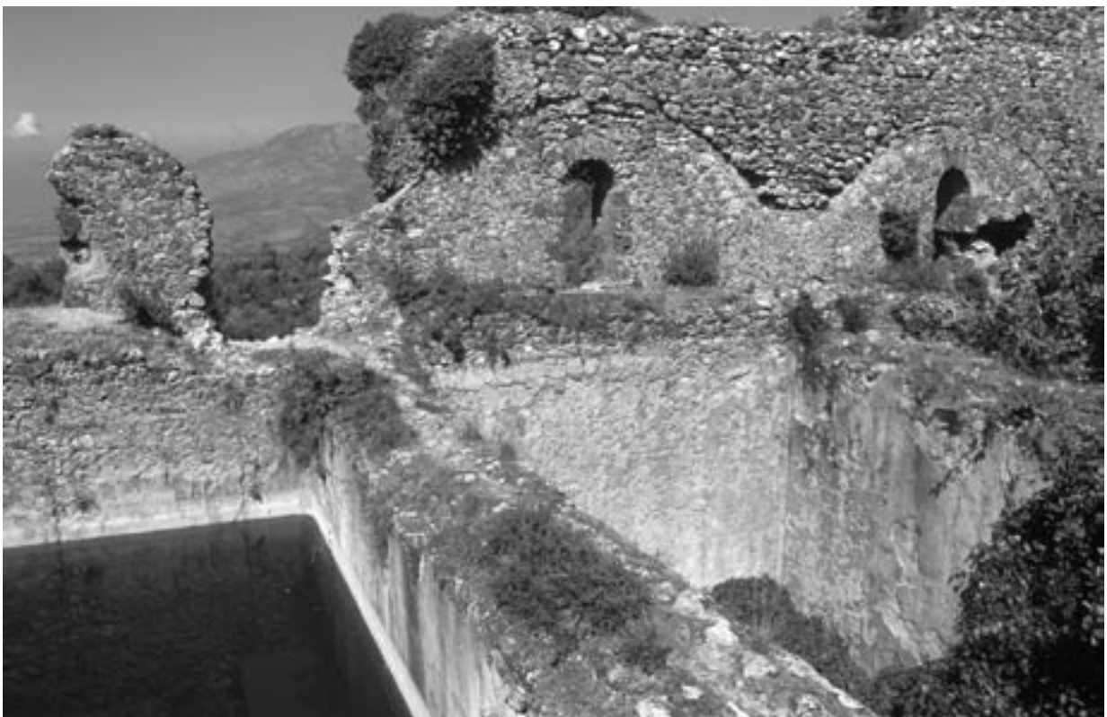
387 Syedra/Asar Tepe, große, spätrömische Zisterne
