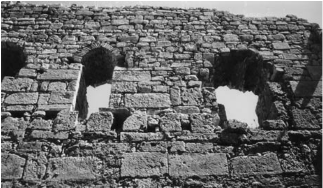
390 Syllaion/Kocahisar bei Yanköy, Praetörion, nördliche Fensterfront (innen)
