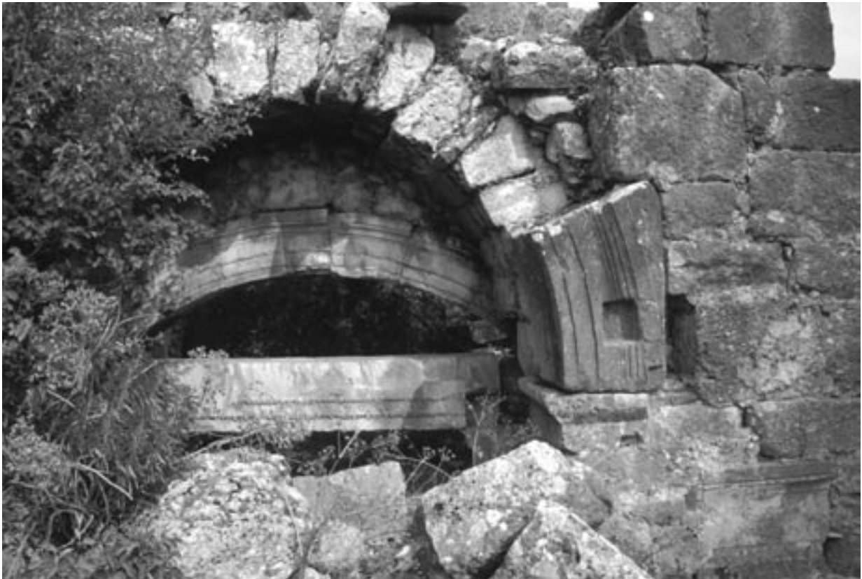
403 Tlōs/Düver, Tor der frühbyzantinischen Stadtmauer mit Inschrift des Statthalters Phl. Kl. Spud(asios?) Markeianos ( TAM II/2 553) auf dem Sturzbalken
