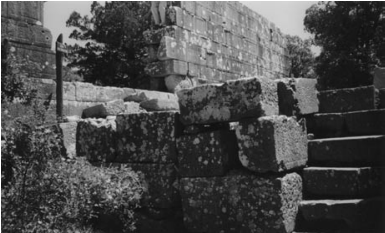
402 Termēssos, Spolienmauer des frühbyzantinischen Kastrons mit kaiserzeitlicher Eingangstreppe
