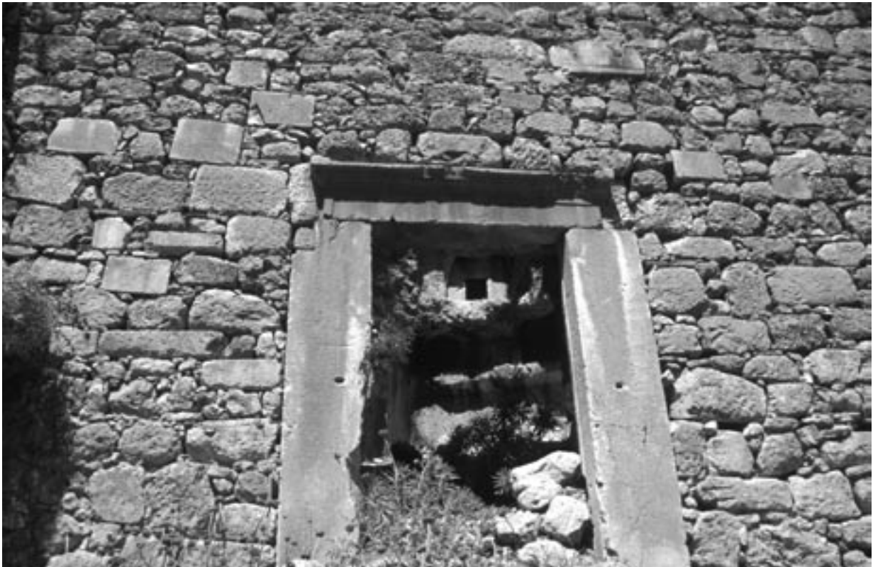
420 Trebenna/Tramita Harabeleri, Tor (mit römischen Spolien) der mittelbyzantinischen Stadtburg/Kastron
