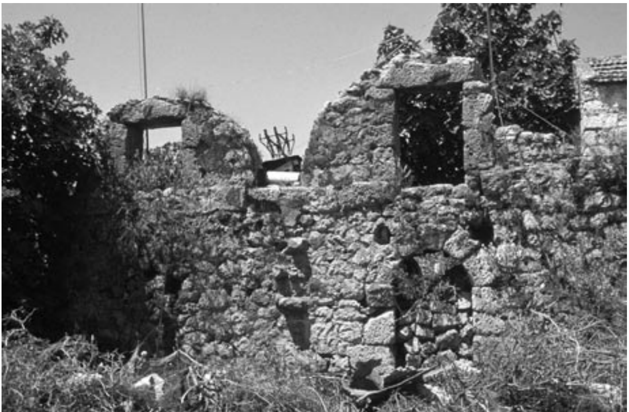
423 Tristomon/Üçağız, spätrömisch/frühbyzantinisches Haus mit Tonnengewölben
