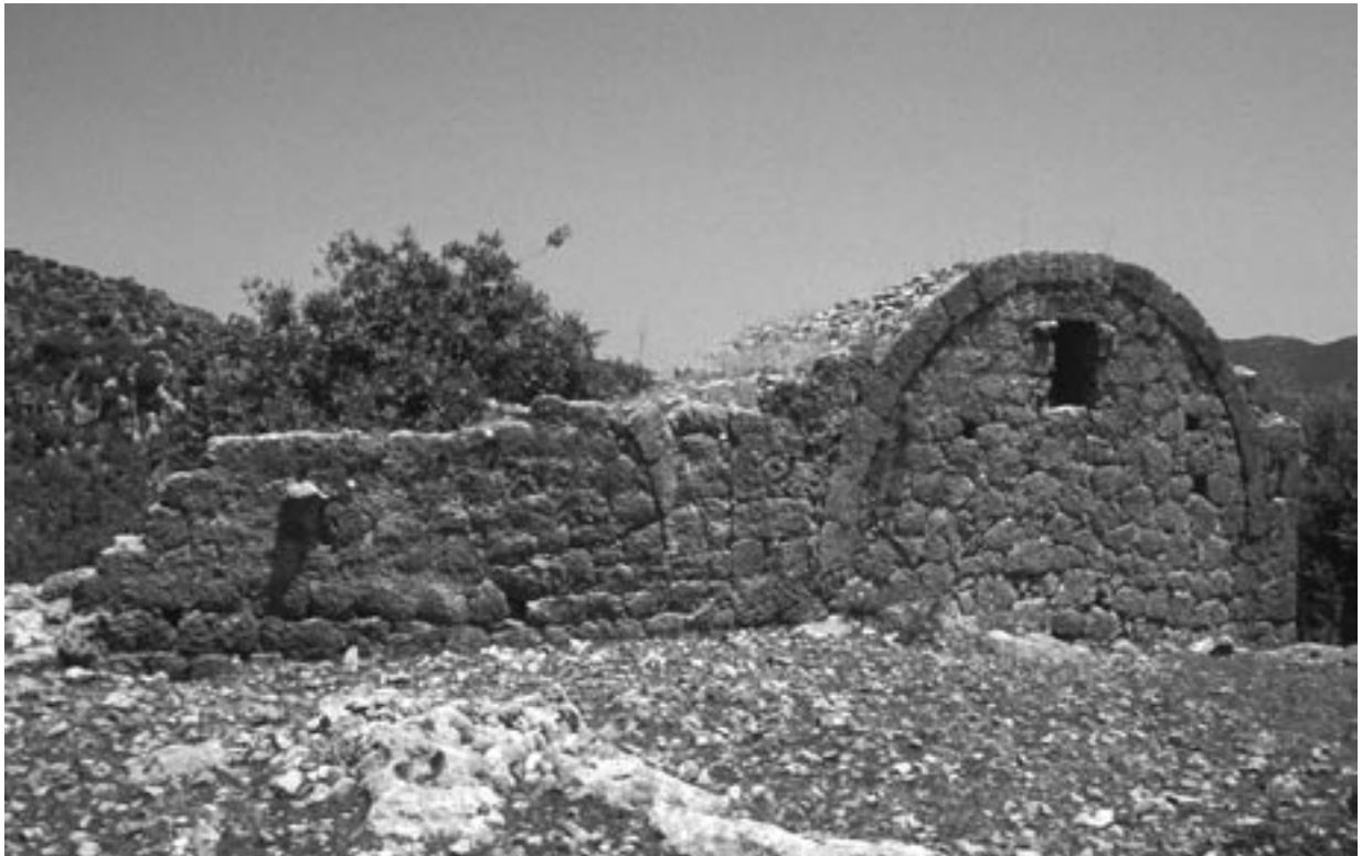
426 Tristomon/Üçağız, spätrömisch/frühbyzantinische Häuser mit Tonnengewölben
