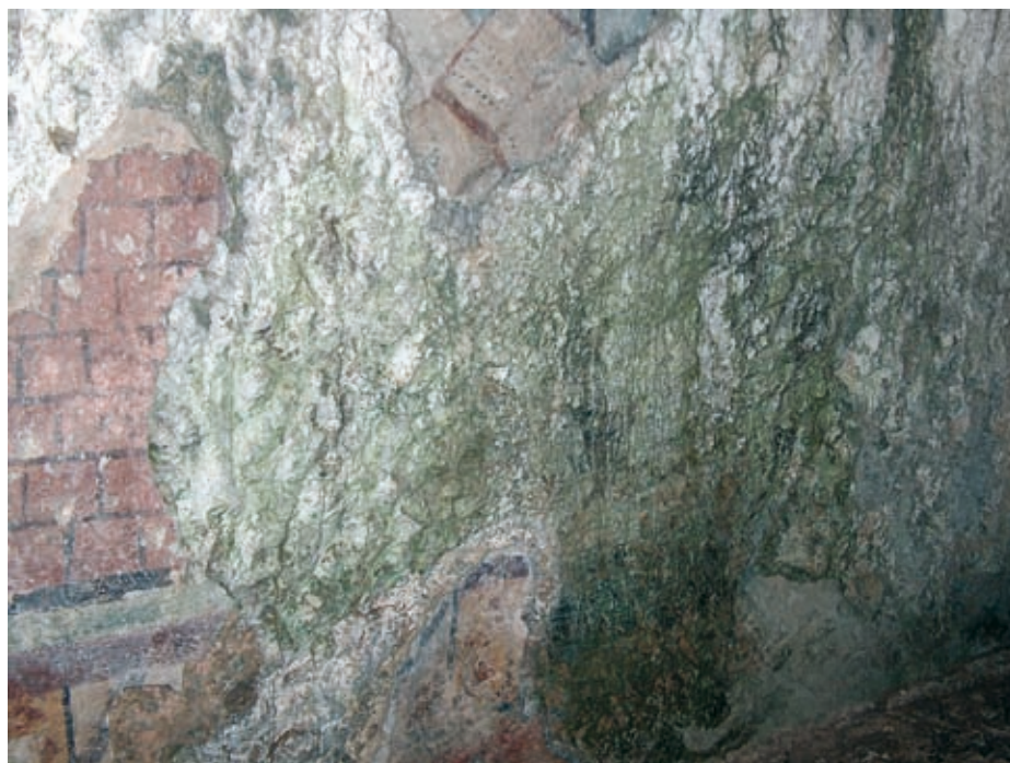
Abb. 21: Großflächige Vergrünung der Oberfläche im Bereich der Paulusszene infolge des Befalls durch Algen und Cyanobakterien.
