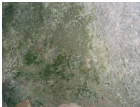
Abb. 33: Belag aus Algen und Cyanobakterien, der sich im Zuge des Trocknens abhebt; große Aushöhlung in der Westwand, rechts vom Eingang.
