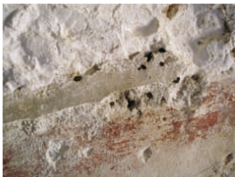
Abb. 3: Rötlicher Malputz der ersten Schicht am Übergang der Westwand zur Decke, mit Resten einer roten Architekturmalerei.
