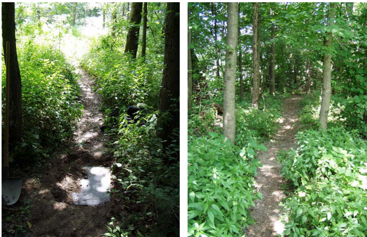
Fotos 3-5: Einbau der Druckmatte (links); Trampelpfad nach Einbau der Druckmatte (rechts)
