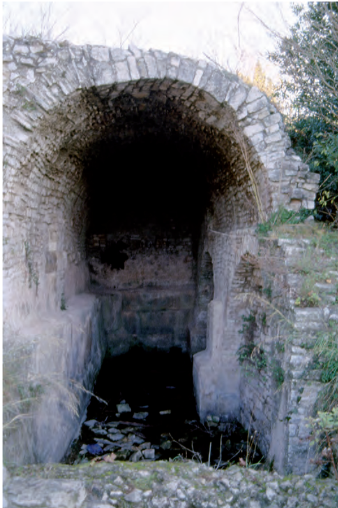
Abb. 28: Piscina am Hafenkastell, heutiger Zustand.
