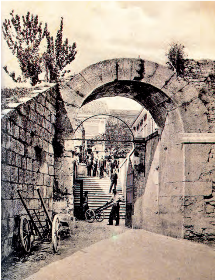
Abb. 18: Herkulesthor mit dahinterliegendem Gasthaus samt Garten in einer historischen Aufnahme
