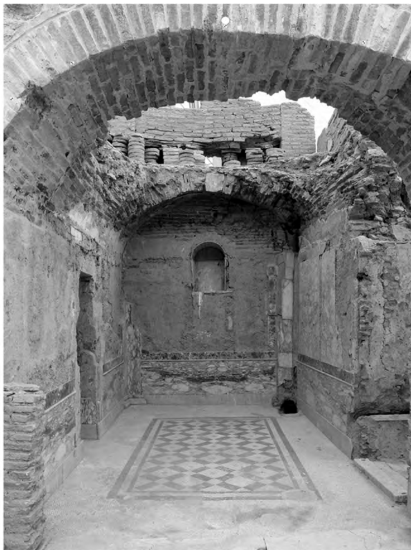
Abb. 15: Raum 36c, Gesamtansicht mit Hypokaustum im OG
