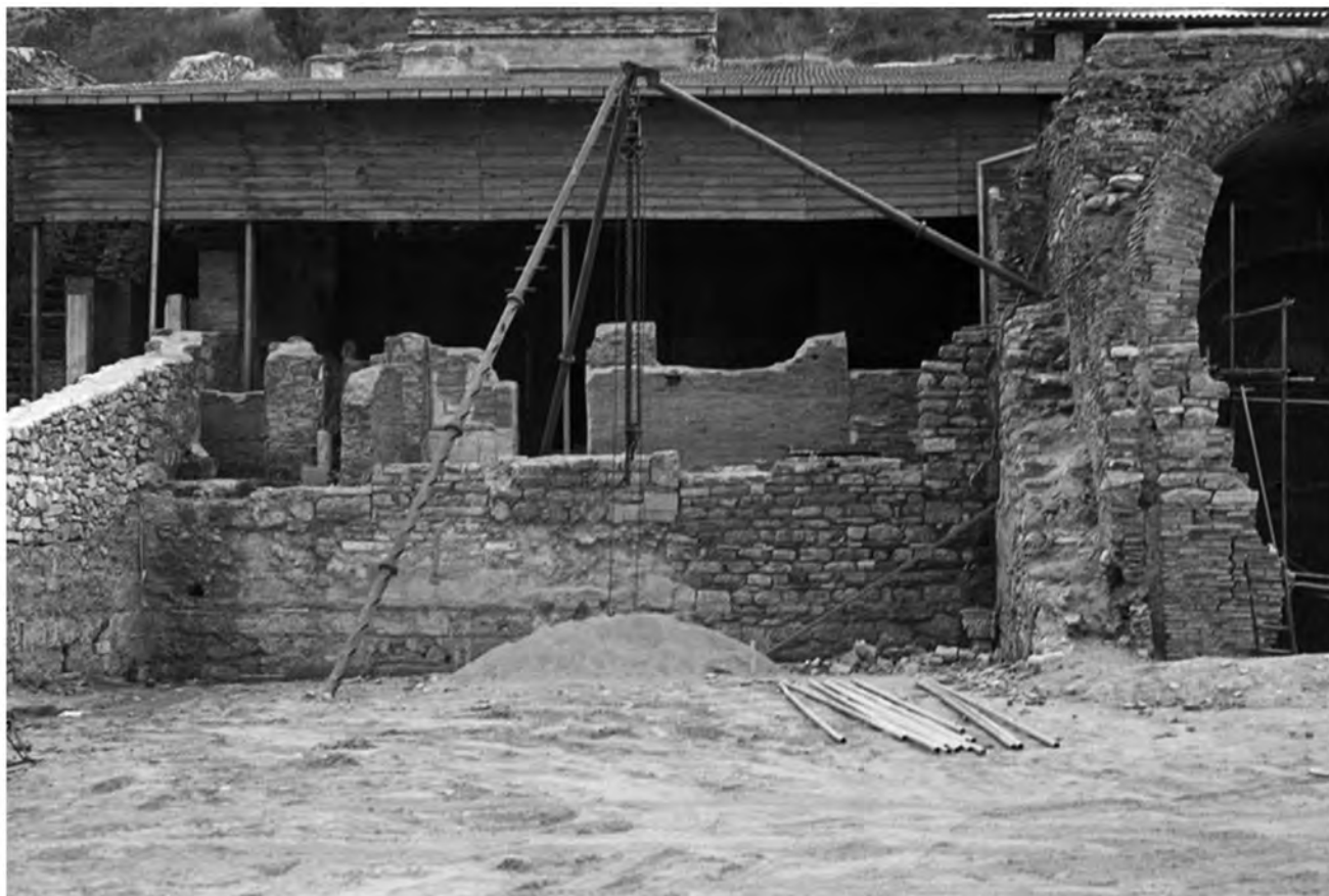
Abb. 6: S-Teil des Marmorsaals 31 vor der Freilegung
