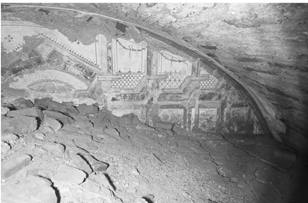
Abb. 22: Schuttverfüllung im Gewölberaum 36a
