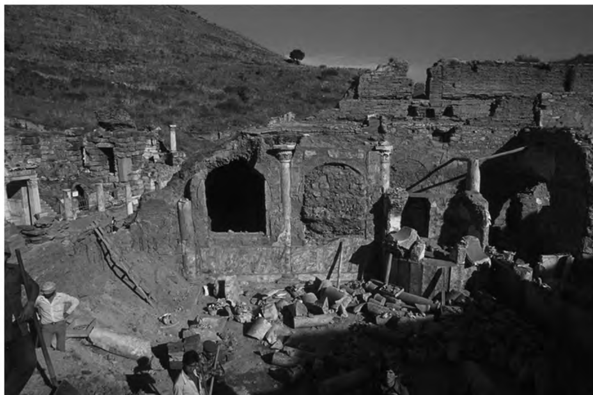
Abb. 17: Peristylhof 31a, O-Halle mit SO-Apsisbecken nach Einsturz und Abtragen der Halbkuppel
