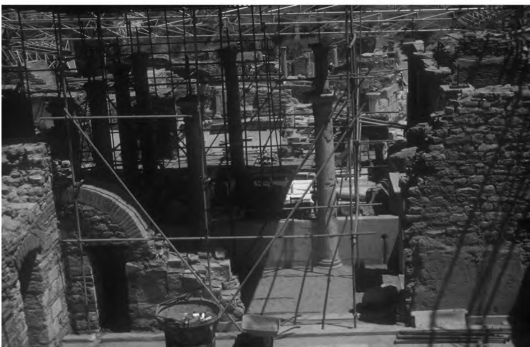
Abb. 46: Montage der Stahlkonstruktion des Schutzbaus im Jahr 2000
