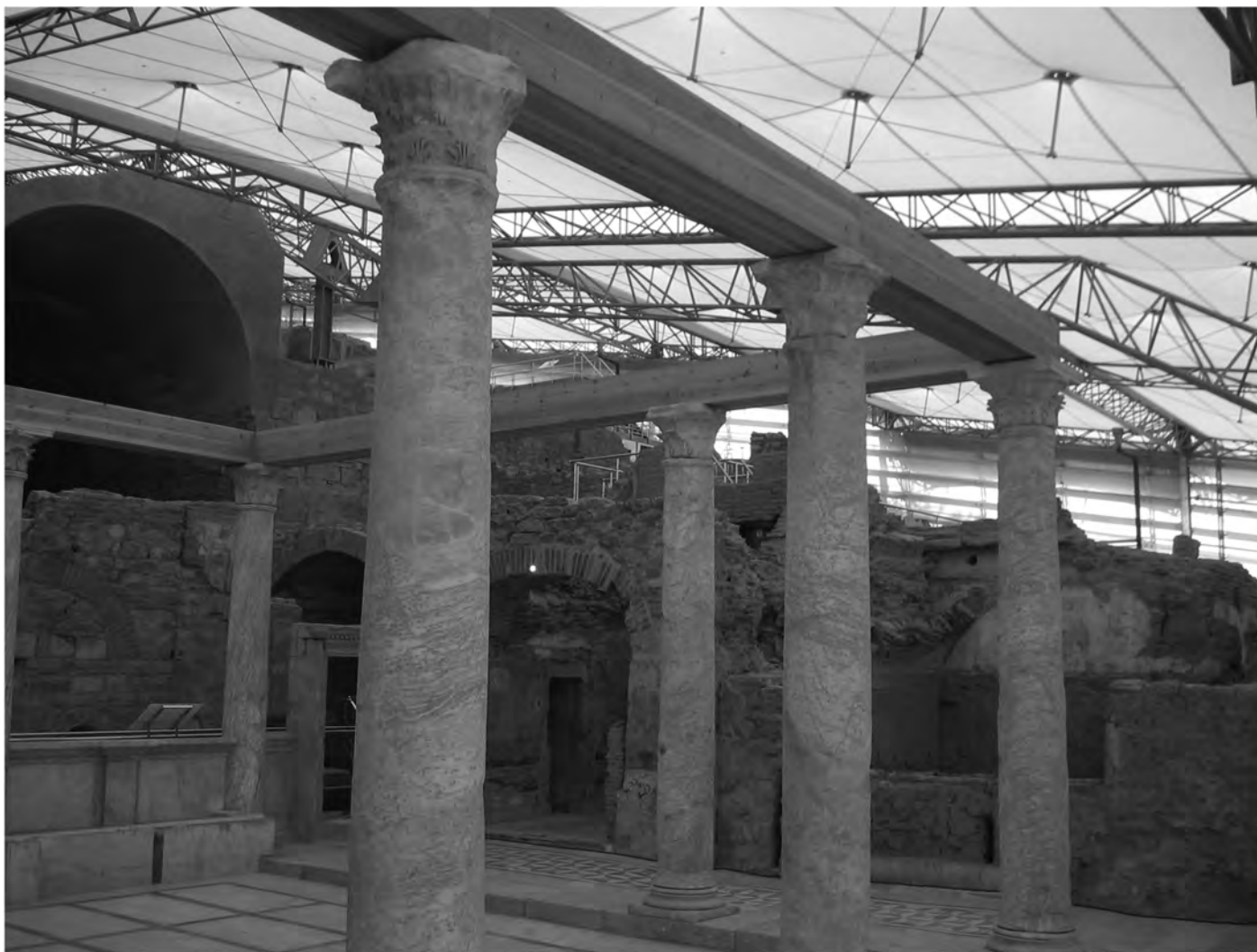
Abb. 3: Peristylhof 31a mit wieder aufgestellten Säulen und rekonstruiertem Holzarchitrav
