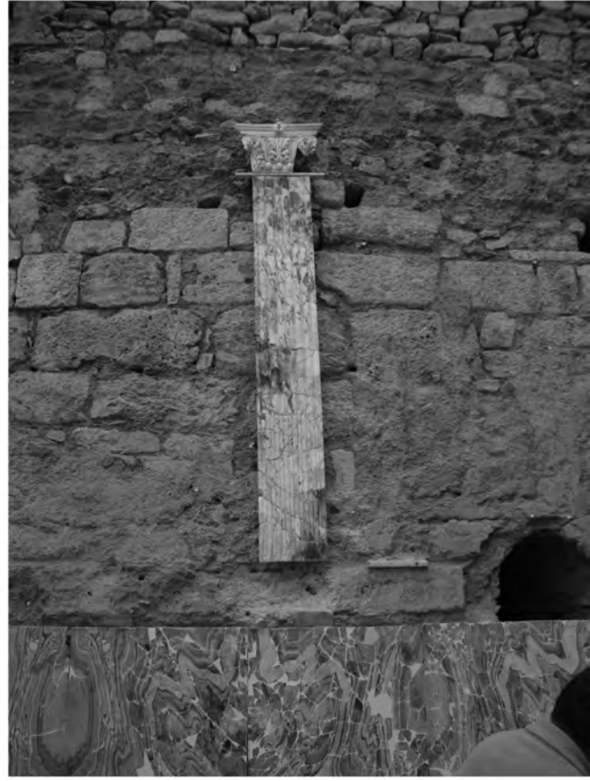
Abb. 13: Marmorsaal 31 O-Mauer, Hinterfüllmörtel der Vertäfelung
