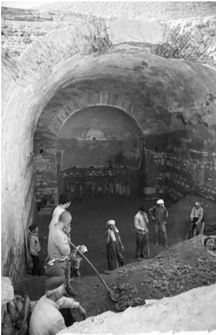
Abb. 4: Freilegung des Apsidensaals 8
