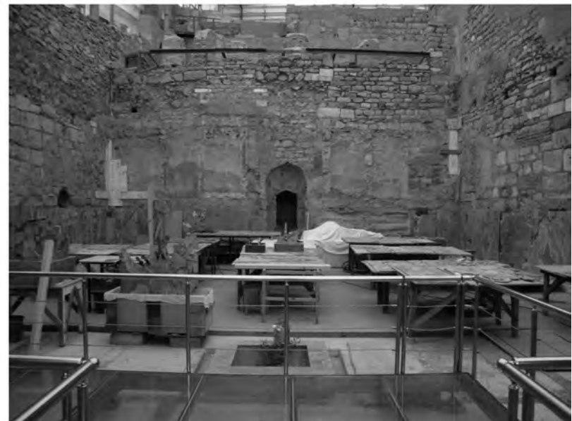
Abb. 50: Restaurierungsarbeiten im Marmorsaal 31 im Jahr 2005
