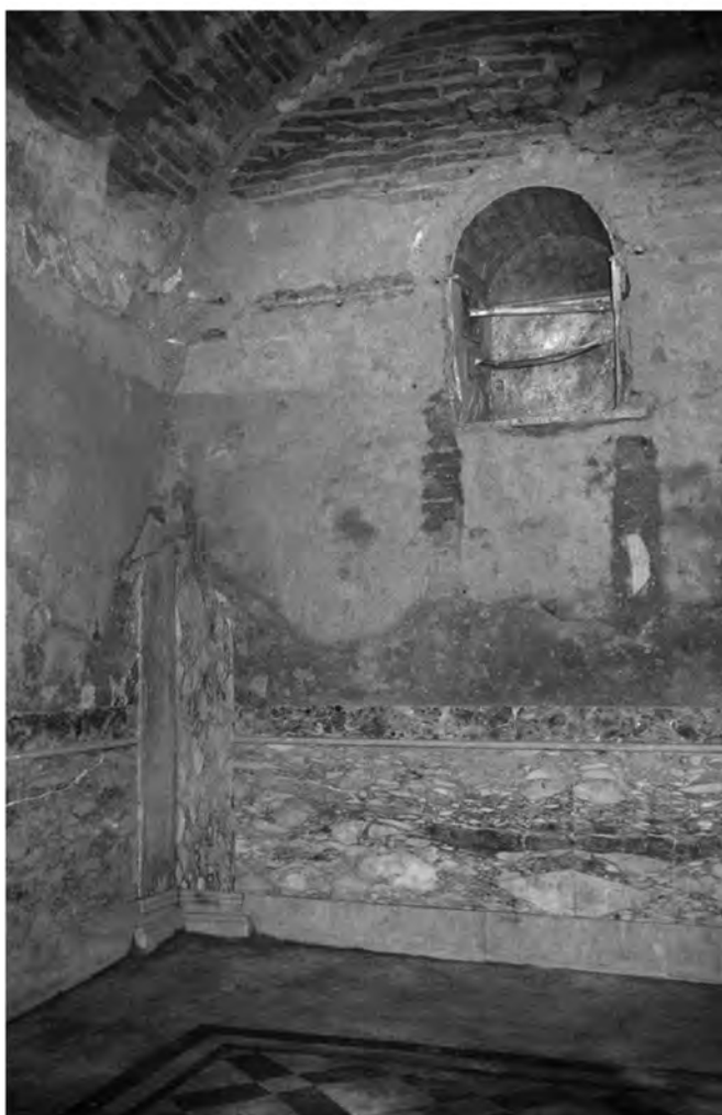
Abb. 30: Raum 36c mit Nische in der W-Mauer
