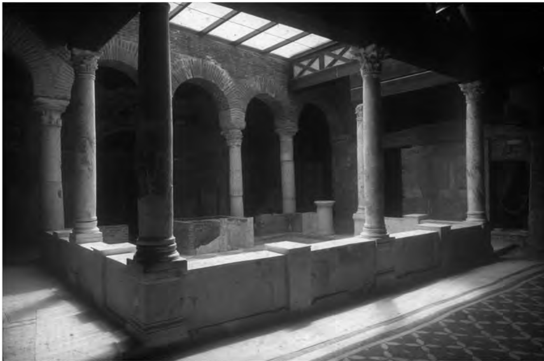
Abb. 44: Peristylhof SR 22/23 in der WE 2 mit Schutzbau 1985
