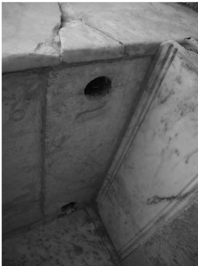
Abb. 11: Peristylhof 31aS, Wasserbecken WB-A3, Wassertüberlauf
