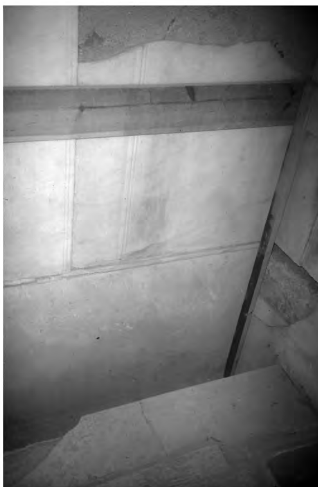
Abb. 17: Latrine 36bL, W-Mauer mit Kanal
