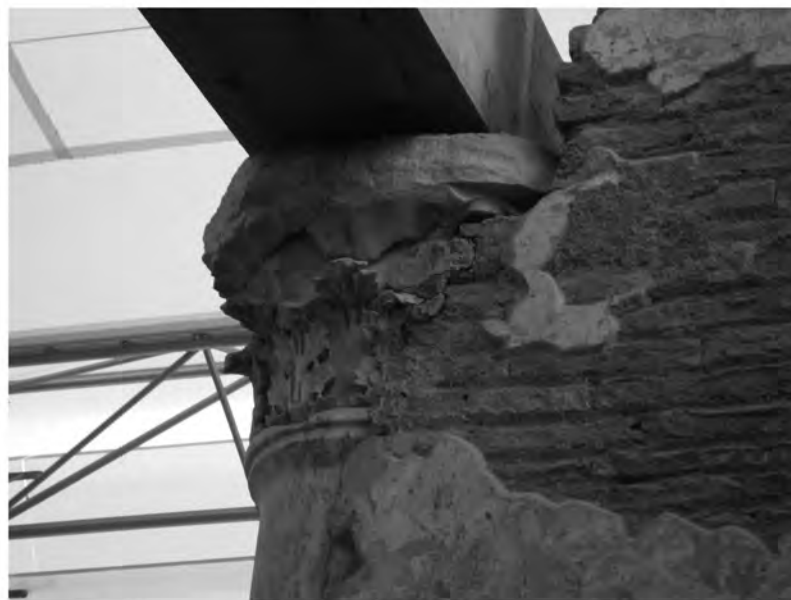
Abb. 7: Baderäume 31aO/M1 und 31aO/M2, Ziegelmauerwerk Typ 7
