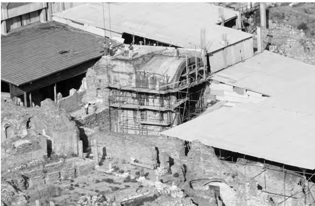
Abb. 45: Ergänzung der Betontonne über dem Apsidensaal 8
