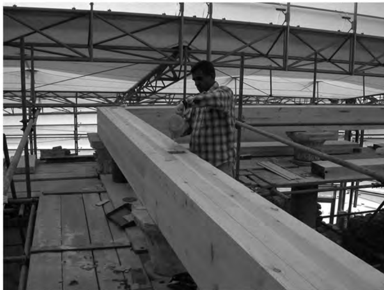
Abb. 42: Peristylhof 31a, Rekonstruktion der Architravbalken
