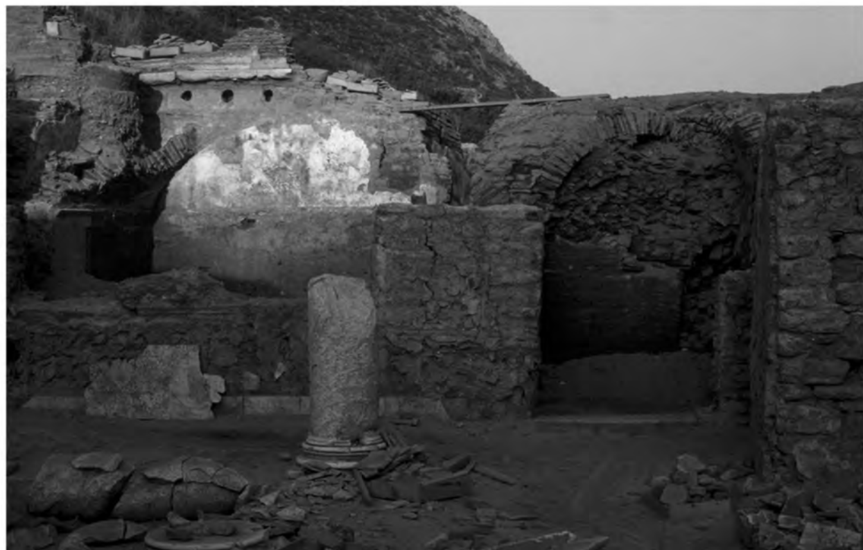
Abb. 14: Raum 36d, Balkenlöcher in der W-Mauer
