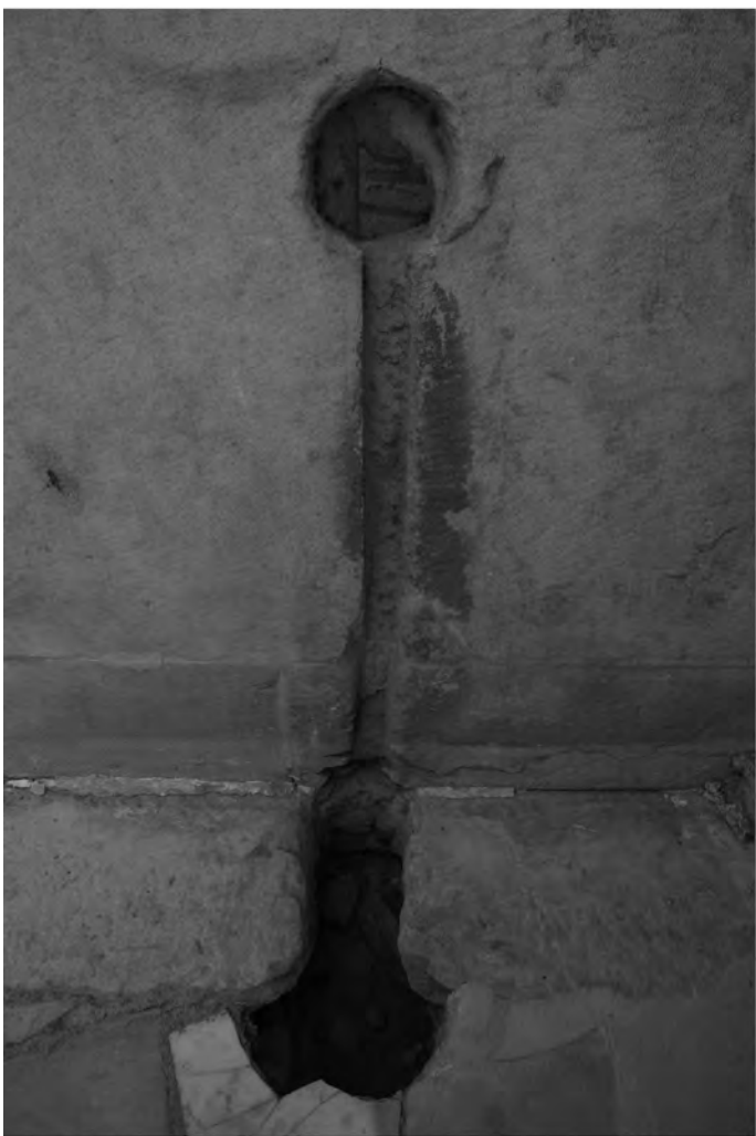
Abb. 10: Peristylhof 31aS, Wasserbecken WB-A3, Wasserzuleitung im S-Umgang
