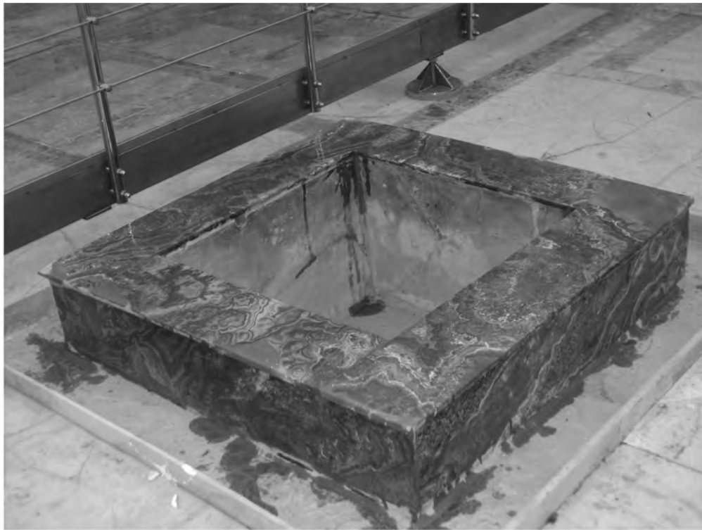
Abb. 22: Marmorsaal 31, Bodenwasserbecken WB-A4 im N-Teil
