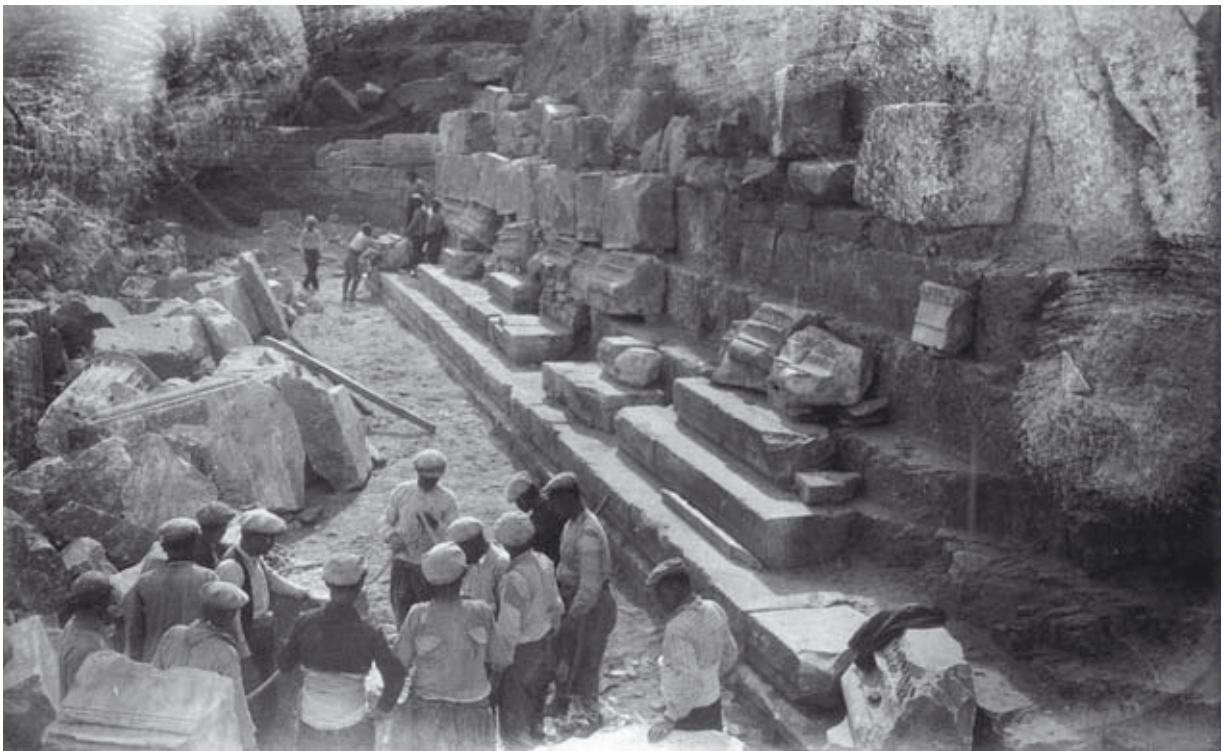
Taf. 14, 2: Vollständig freigelegter Stufenunterbau der Ostseite (1933)
