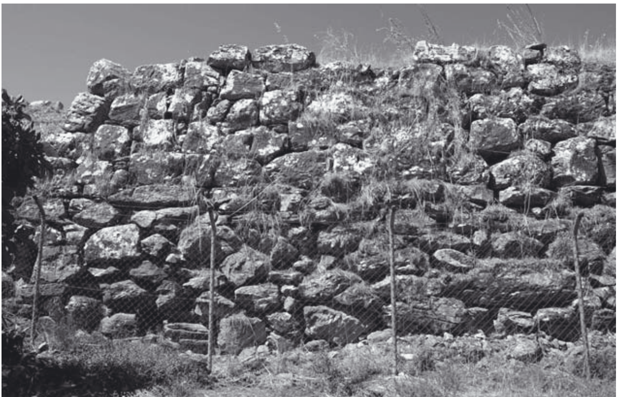
Taf. 28, 2: Terrassenmauer, mittlerer Mauerabschnitt mit Ausgleichslage (2002)
