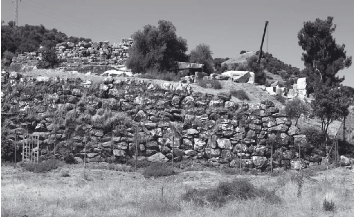
Taf. 28, 1: Nordende der Terrassenmauer (2002)
