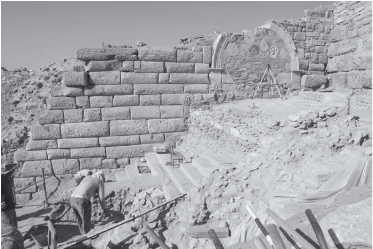
Abb. 486: Zugangspodest ES3 u. Treppe-Ost während der Freilegung 2008, von SW
