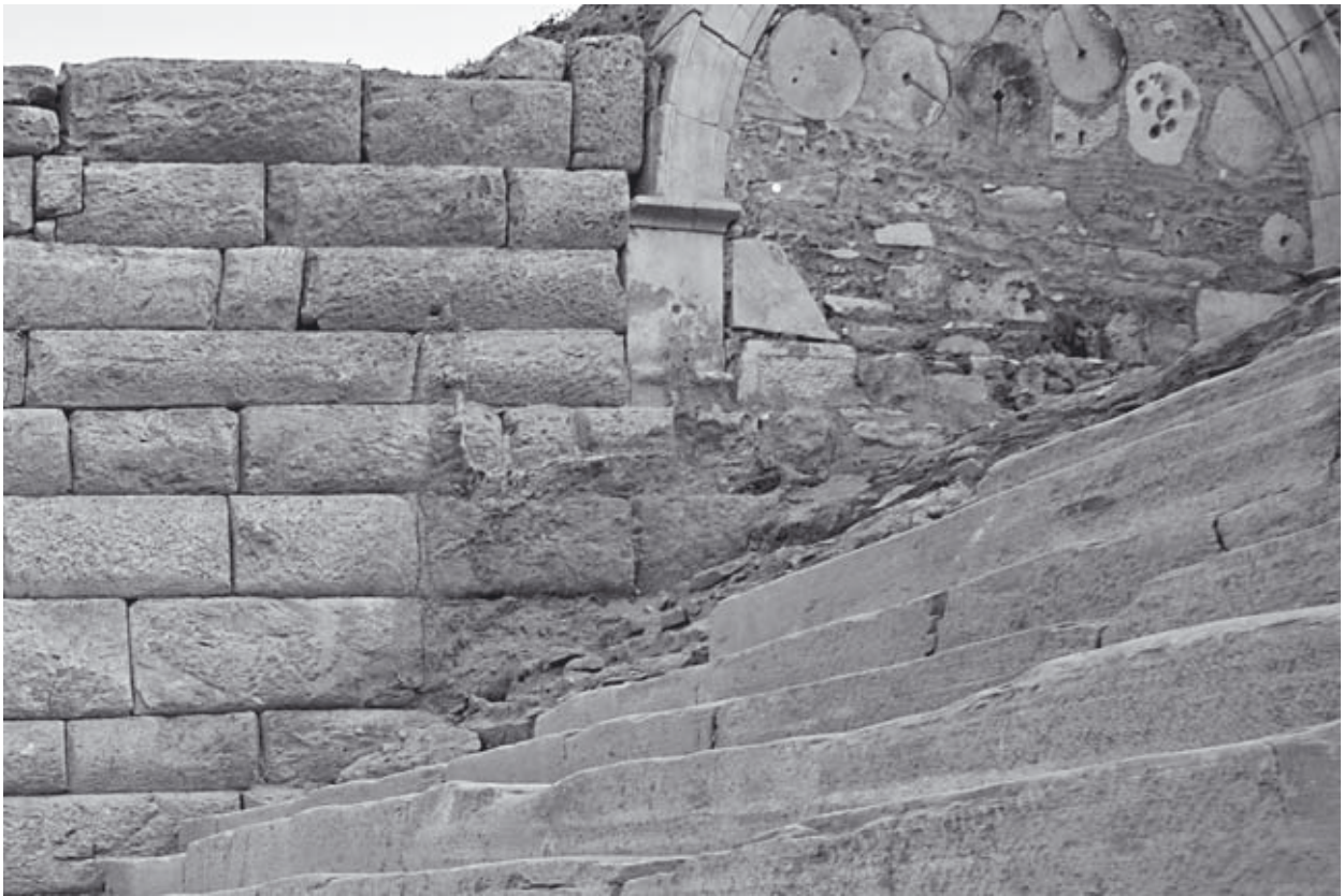
Abb. 455: Versinterungsreste des Brunnenbeckens westlich ES3
