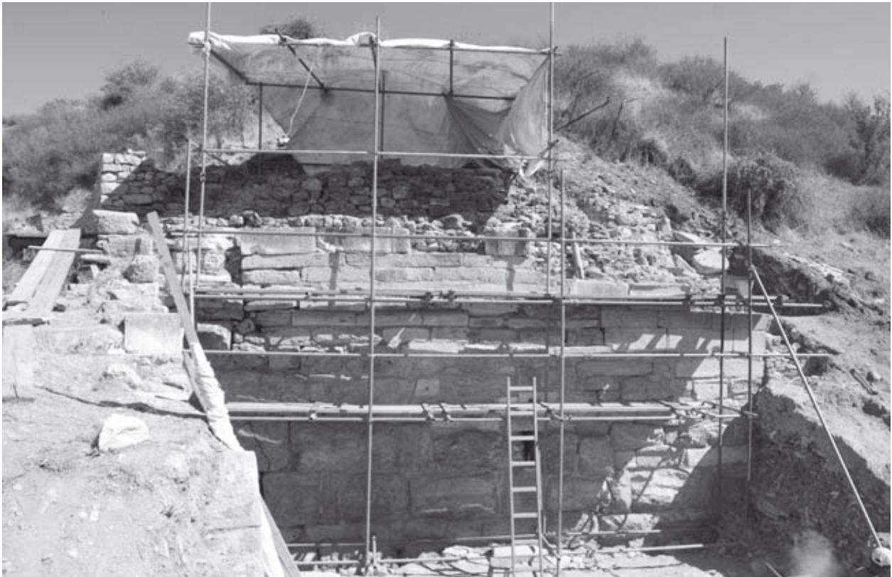
Abb. 416: Zugangspodest ES3, byzantinische Stadtmauer während der Freilegung 2007, von W
