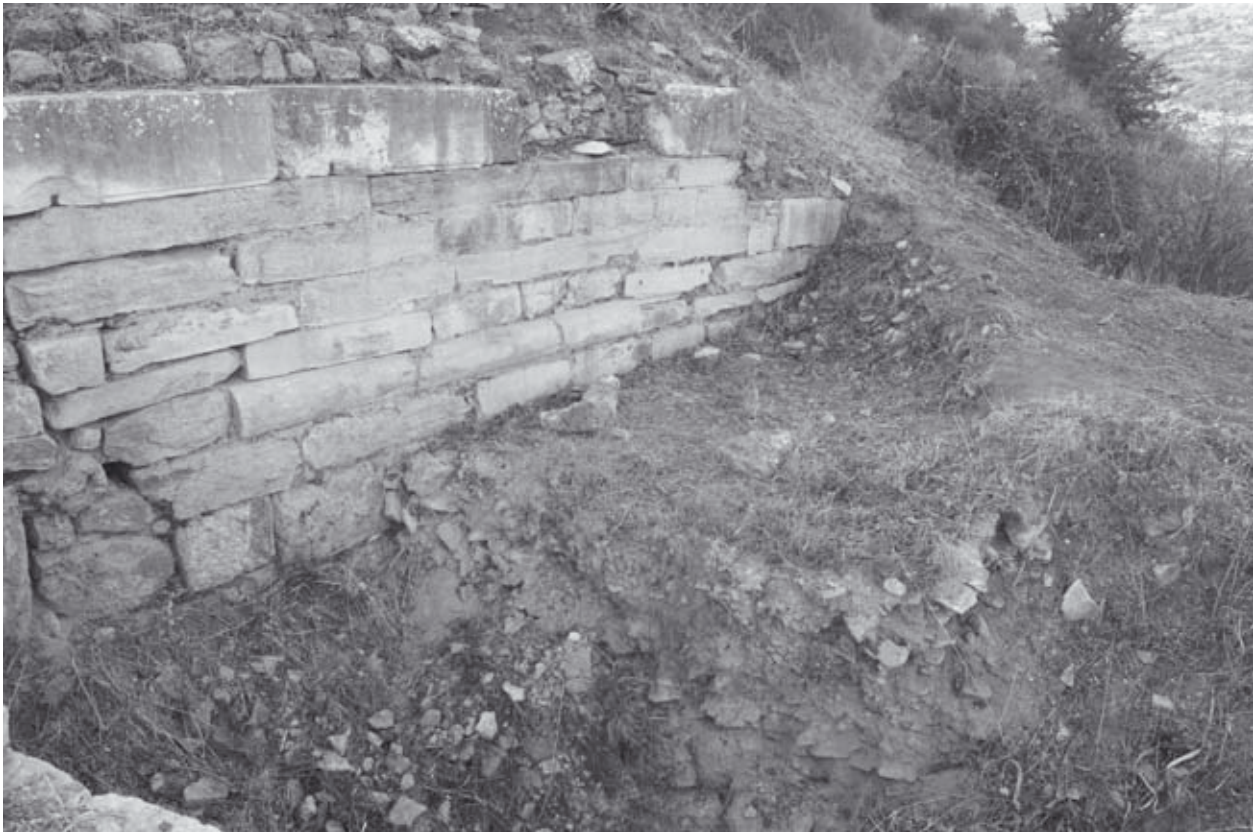
Abb. 411: Zugangspodest ES3 mit byzantinischer Stadtmauer (2007), von NW
