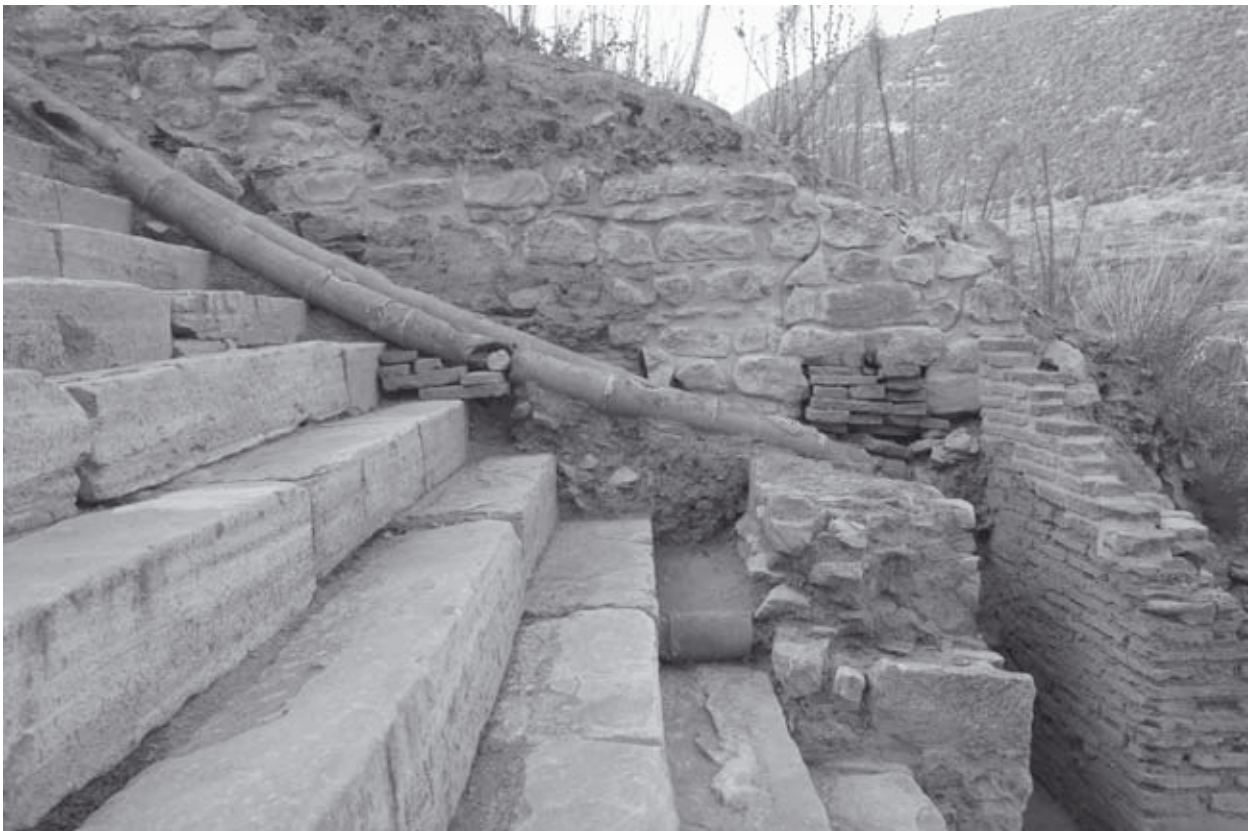
Abb. 492: Treppe-Ost, Insulamauer MA10 mit TRL 17 u. 18, westlicher Abschnitt, von N
