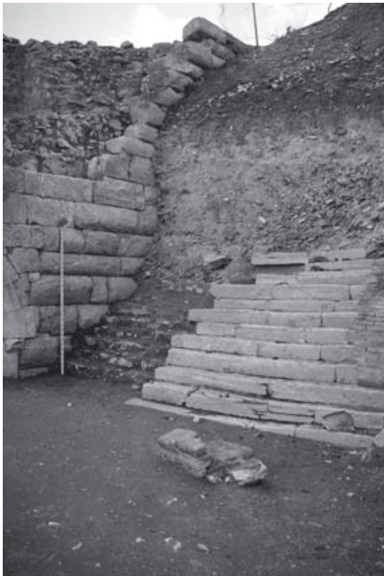
Abb. 398: Treppe-Ost, Profil 1993, von SW
