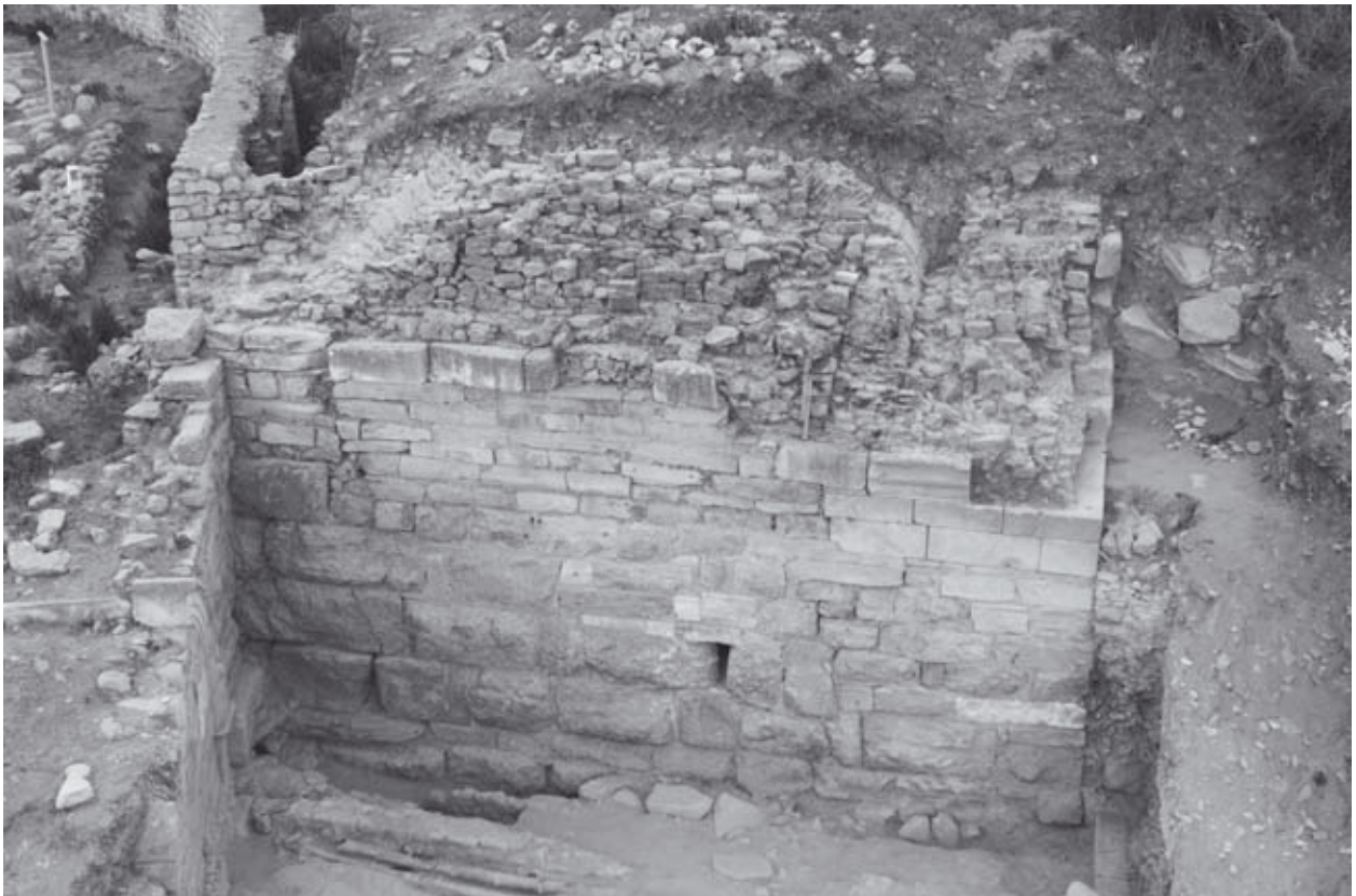
Abb. 442: Zugangspodest ES3, hell. Hangmauer/byzantinische Stadtmauer, W-Ansicht
