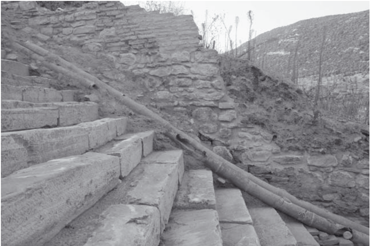
Abb. 491: Treppe-Ost, Insulamauer MA10 mit TRL 17 u. 18, mittlerer Abschnitt, von N
