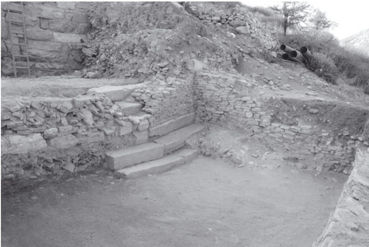
Abb. 462: Später Hallenbau westlich ES3, Südteil mit Treppe-Ost, von NW
