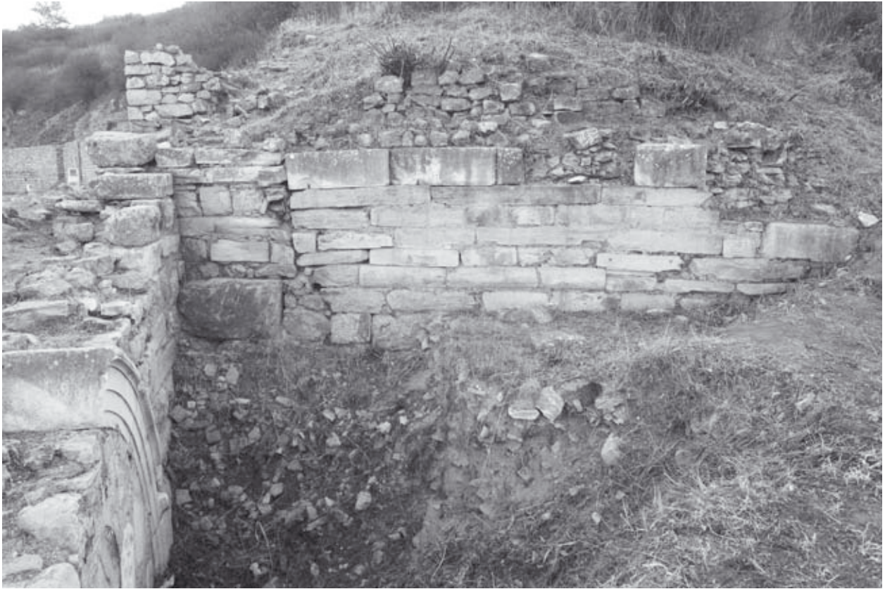
Abb. 410: Zugangspodest ES3 mit byzantinischer Stadtmauer (2007), von W
