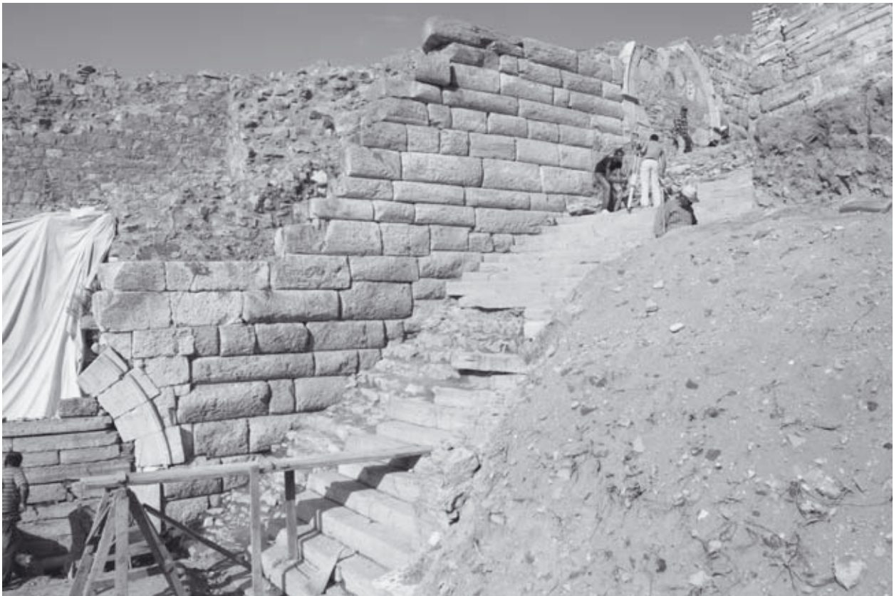
Abb. 487: Zugangspodest ES3 u. Treppe-Ost während der Freilegung 2008, von SW
