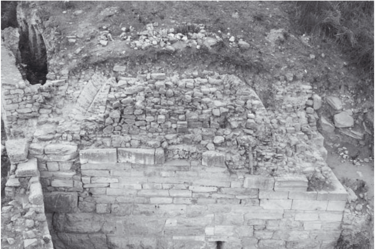
Abb. 443: Byzantinische Stadtmauer, Draufsicht von W
