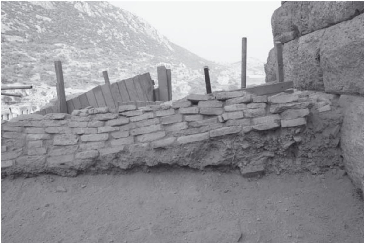
Abb. 469: Später Hallenbau westlich ES3, Westmauer MA6, Nordteil, O-Ansicht
