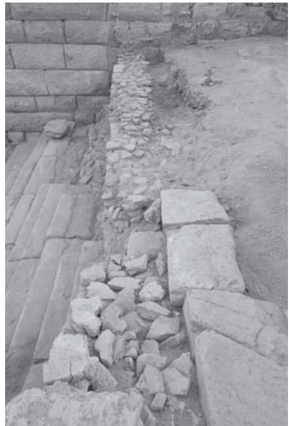
Abb. 471: Später Hallenbau westlich ES3, Ostmauer MA4, S-Ansicht
