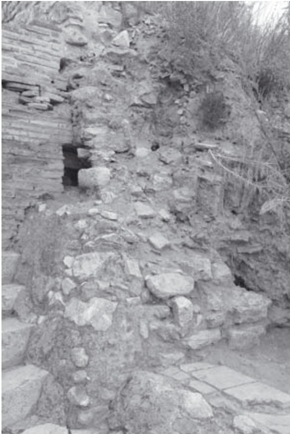
Abb. 514: Zugangspodest ES2, westliches Ende der Insulamauer MA10 u. geböschte Mauer MA17, von NW
