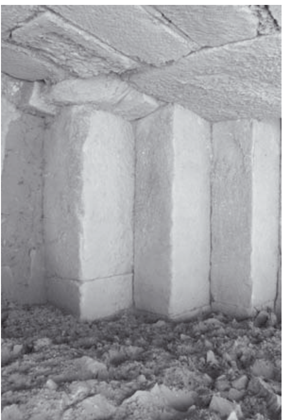
Abb. 565: Treppe-West, Stufen östlich ES1, Situation 2007, von W
