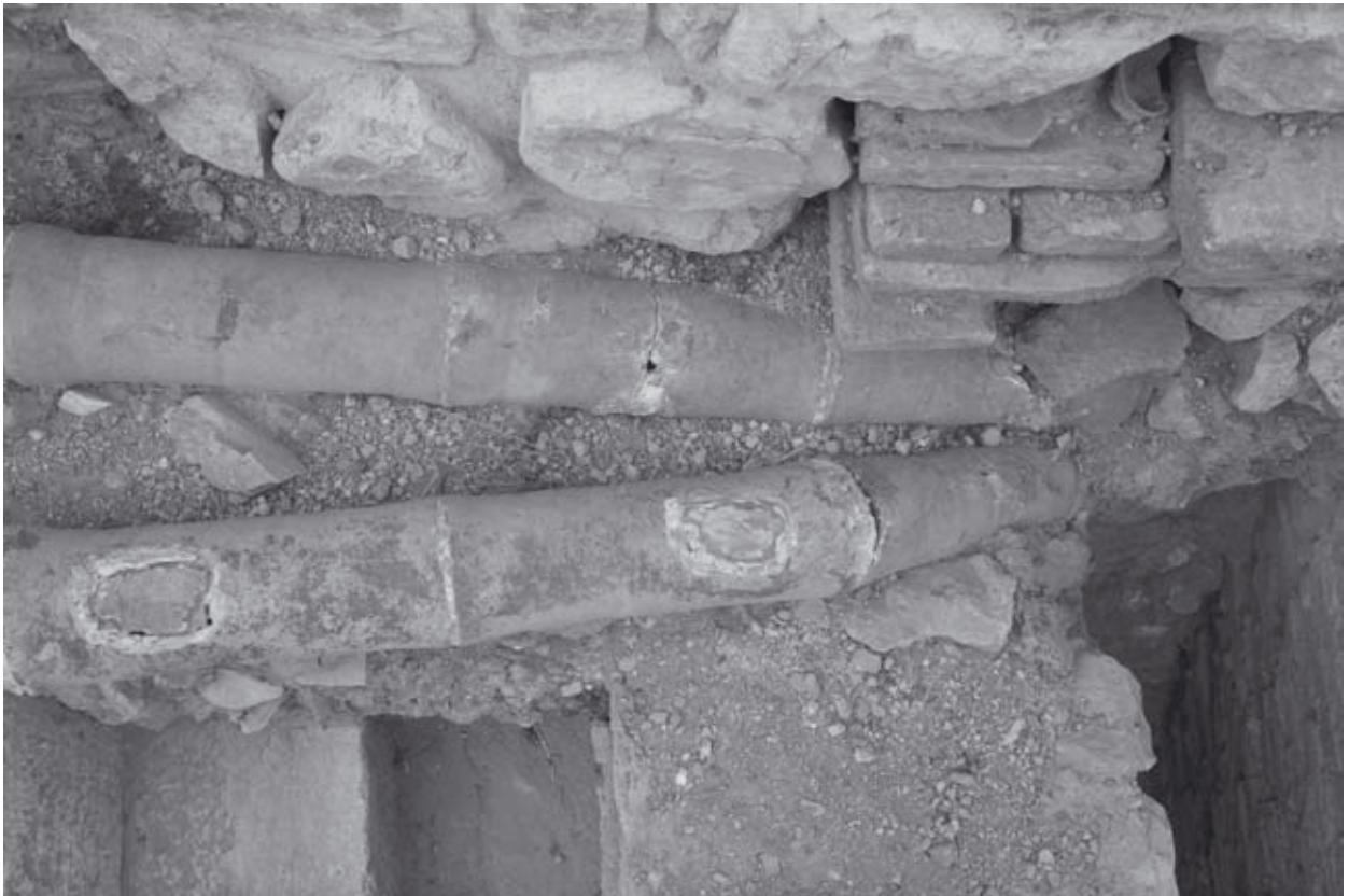
Abb. 496: Treppe-Ost, TRL 17 u. 18, Situation im Bereich von MA14, von N
