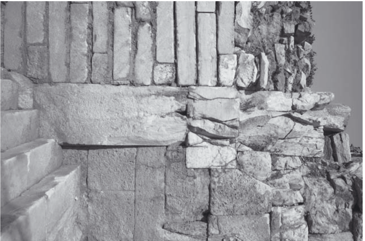
Abb. 581: Zugang ES1, östlicher Torpfiler, von S
