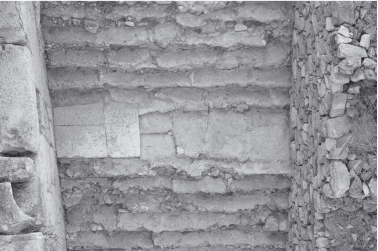
Abb. 572: Treppe-West, Treppenabsatz auf Höhe der oder Türöffnung, von W
