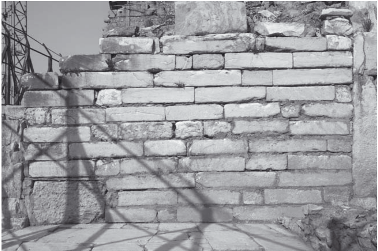
Abb. 582: Mit Stufensteinen verschlossener Zugang ES1, von S
