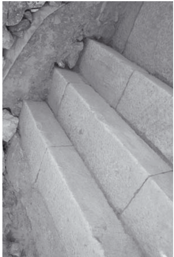
Abb. 568: Treppe-West, Stufen östlich ESI, auf Höhe von MA27 u. MA29, von NW
