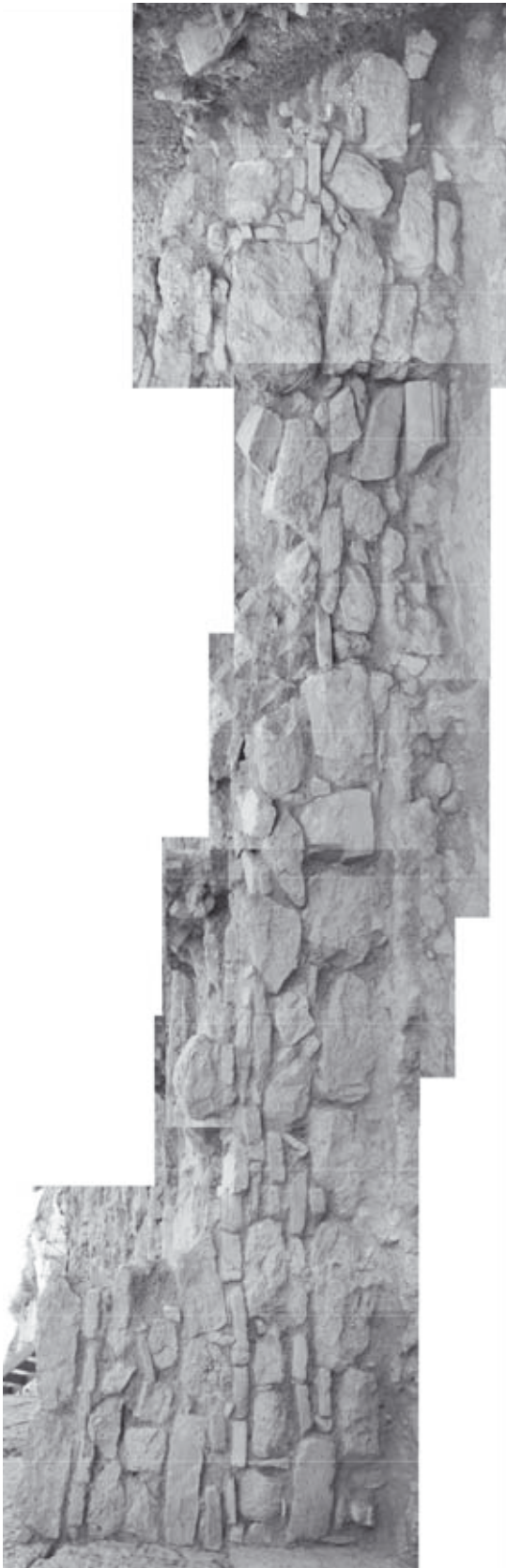
Abb. 539: Treppe-West, MA20, W-Ansicht (Montage)
