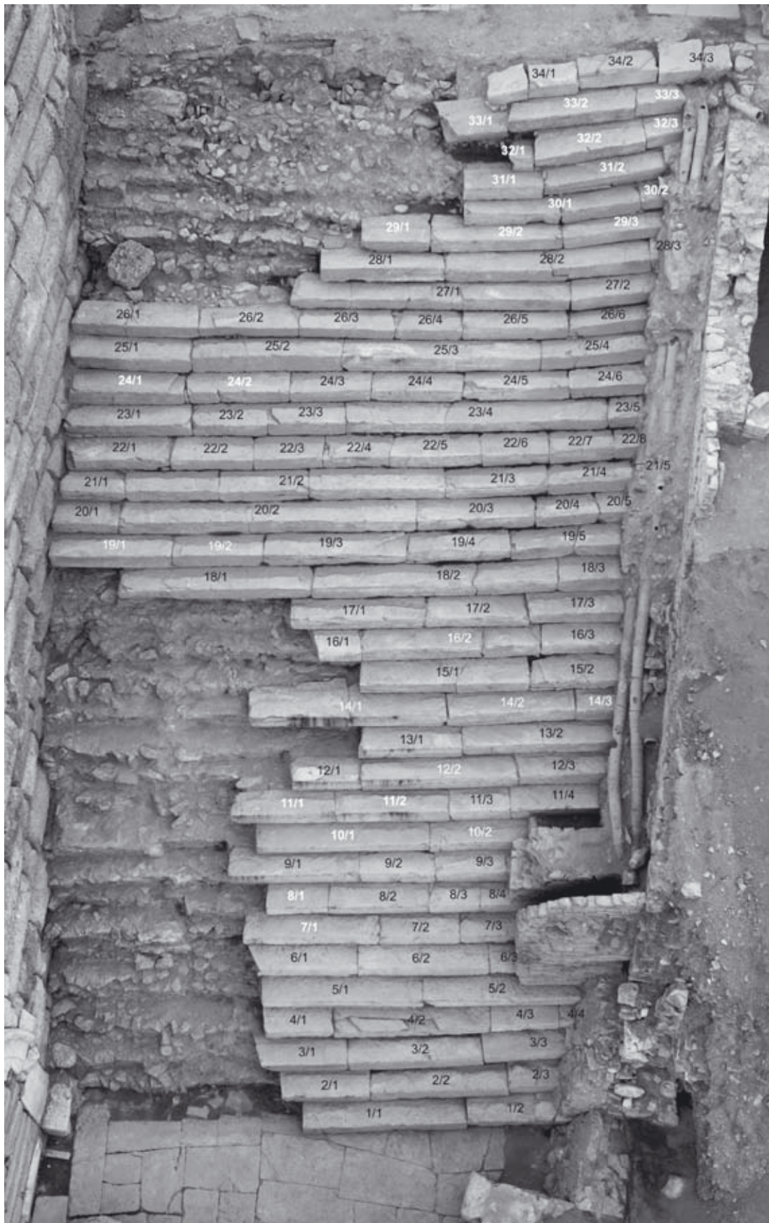
Abb. 589: Treppe-Ost, Übersicht: lfd. Steinnr. (schwarz); Stufensteine m. Versatzmarken u. Steinmetzzeichen (weiß)
