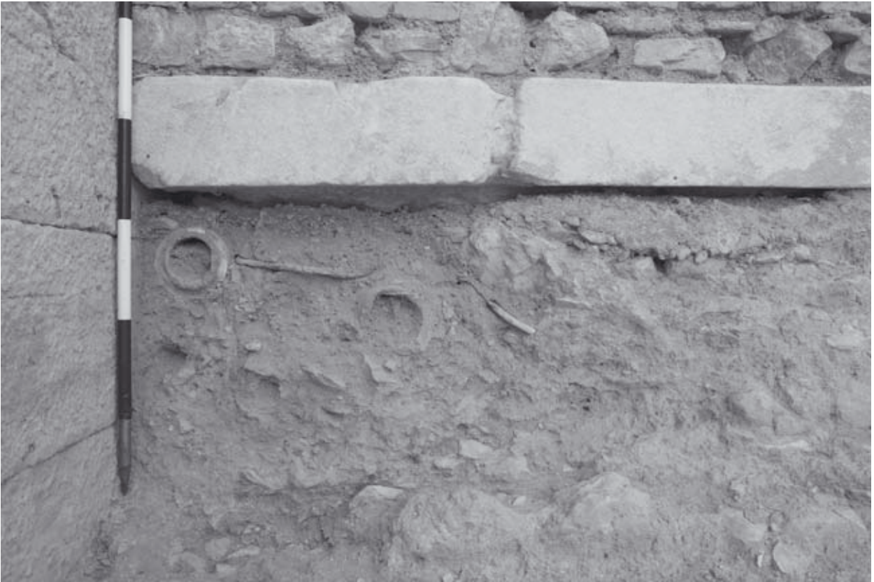
Abb. 557: Treppe-West, Tonrohrleitungen im Profil unter MA23, O-Ansicht
