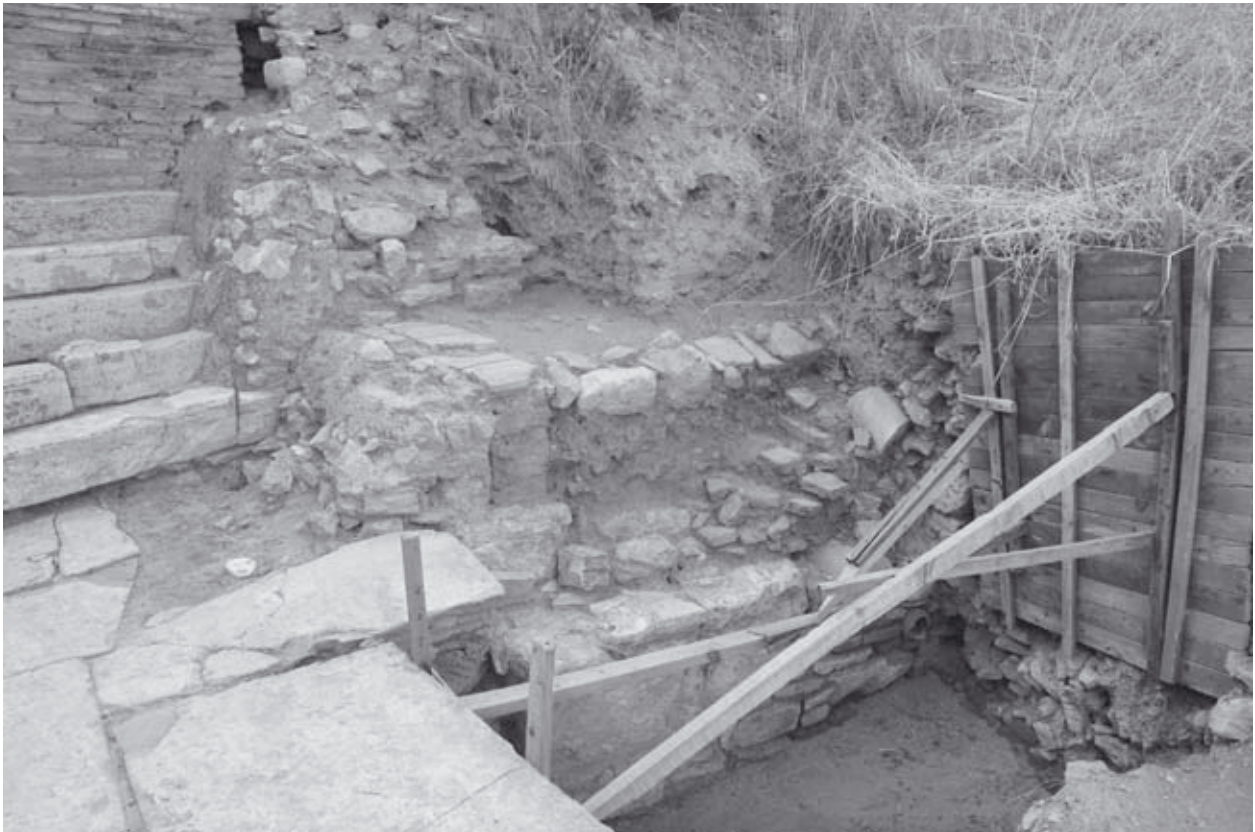
Abb. 515: Zugangspodest ES2, MA10, geböschte Mauer MA17 u. MA34, Raum 2, von NW
