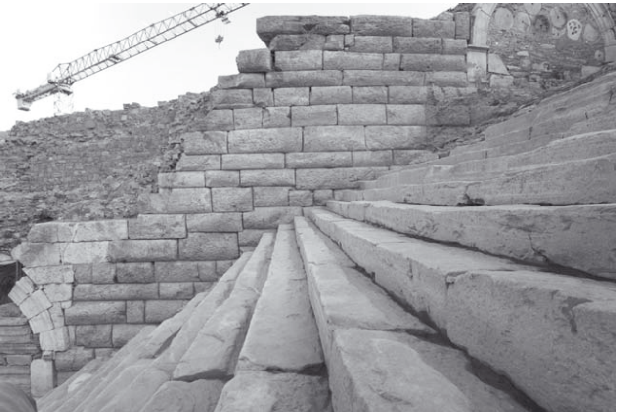
Abb. 501: Ansicht der Fassade zwischen ES2 u. ES3, Ansicht von S
