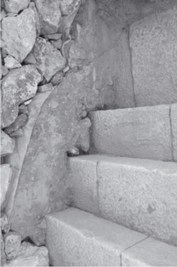
Abb. 567: Treppe-West, Stufen östlich ESI, auf Höhe von MA27 u. MA29, von N
