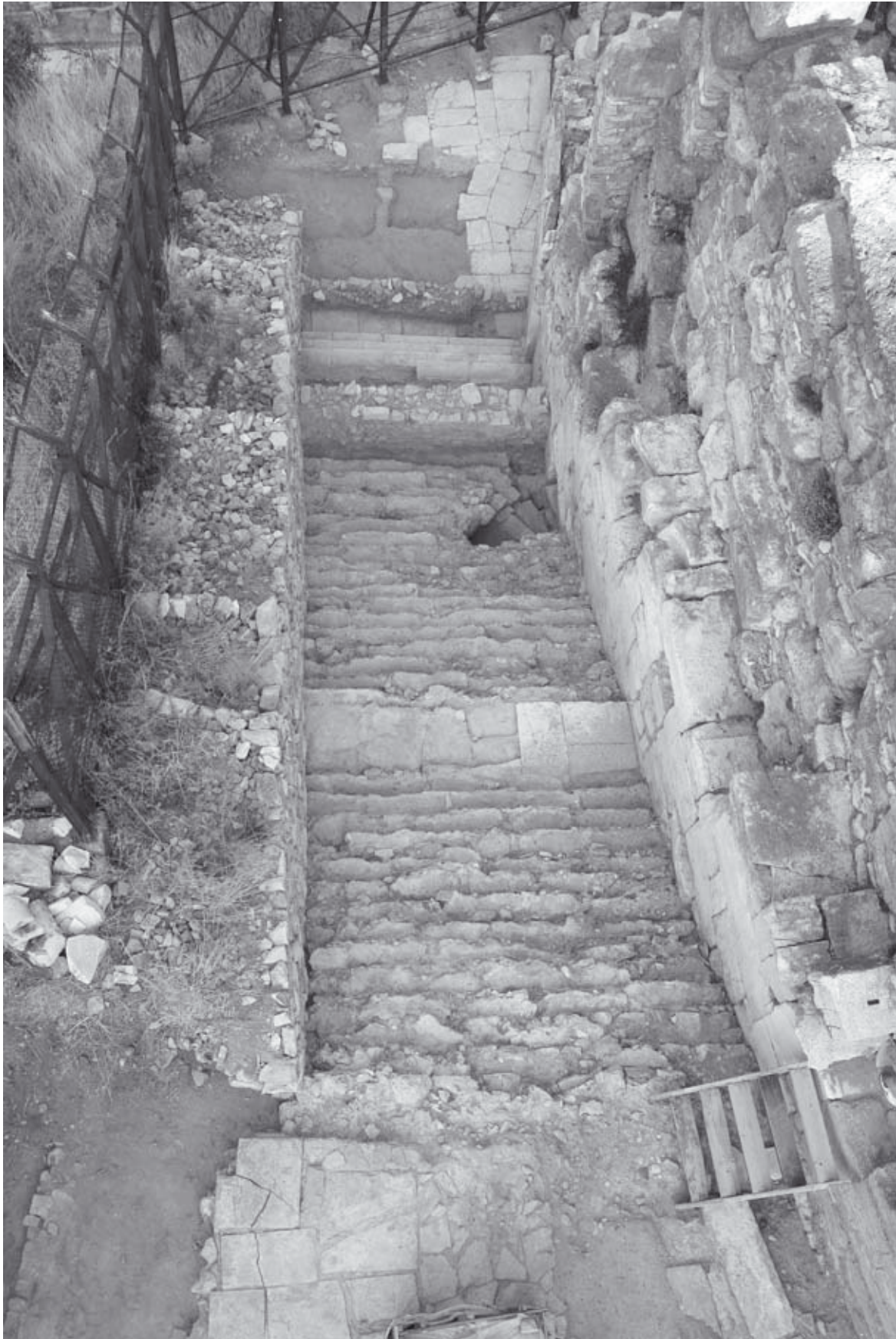
Abb. 571: Treppe-West mit Zugangspodest ES1, von O
