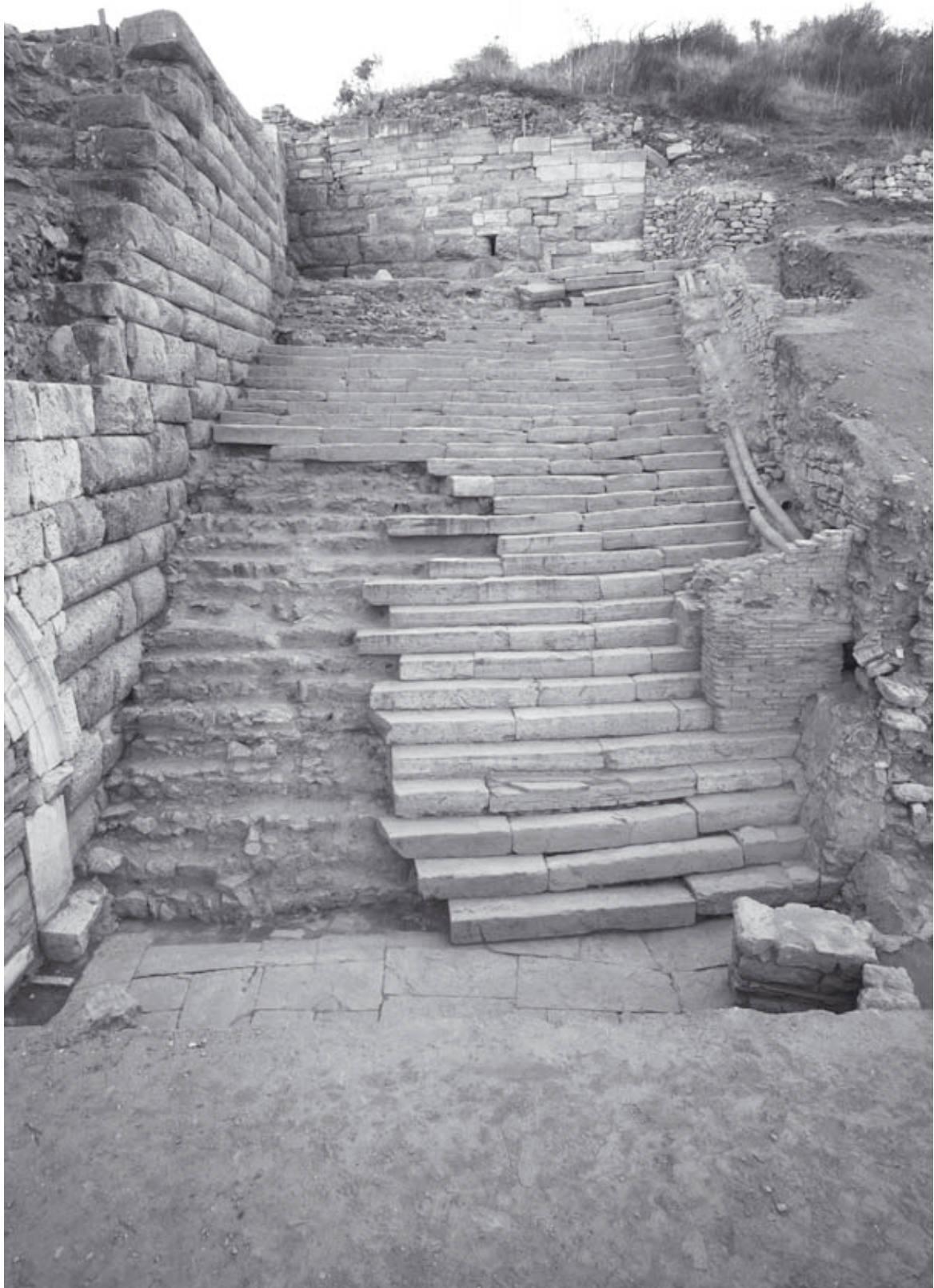
Abb. 503: Treppe-Ost nach der Freilegung 2008, von W
