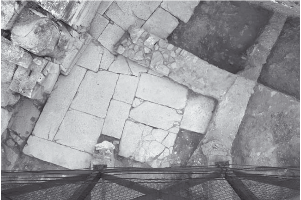
Abb. 576: Zugangspodest ES1 mit MA11, von SW
