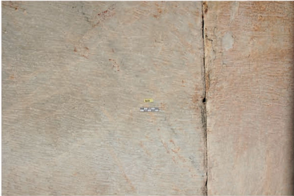
1 Gehackte Oberfläche der Orthostaten 0630 und 0640
