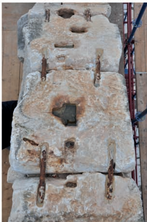
2 Verklammerung an der Oberseite des Bogens
