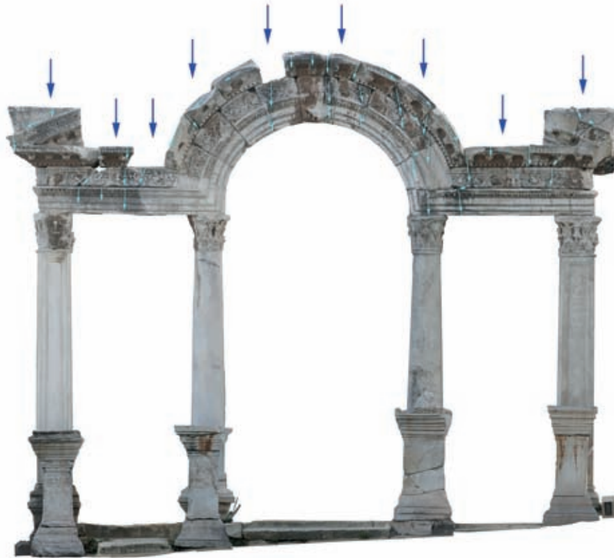
1 Weg des Niederschlagswassers an der Fassade
