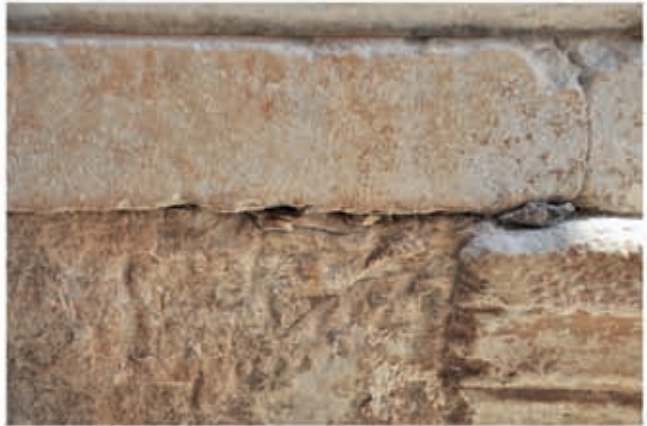
2 Polyesterharz in der Lagerfuge zwischen Basis 023B und Postament 022B des östlichen Pfeilers
