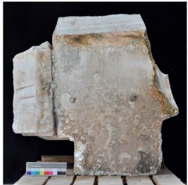
4 Unterseite des östlichen Bogenansatzes 039AF mit zwei Dübelverbindungen zum Architrav
