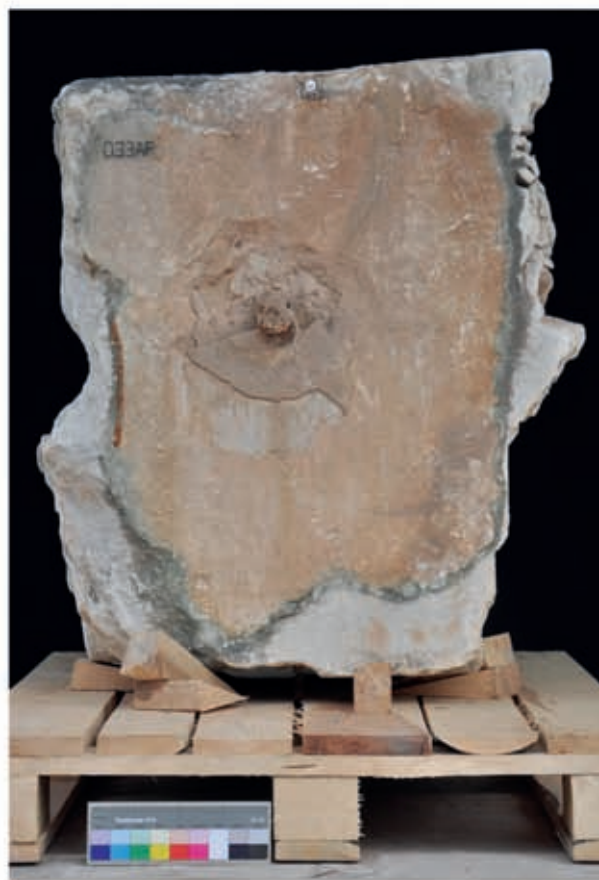
3 Ansicht der Stoßfuge von 033AF mit dem Dübel im oberen Drittel
