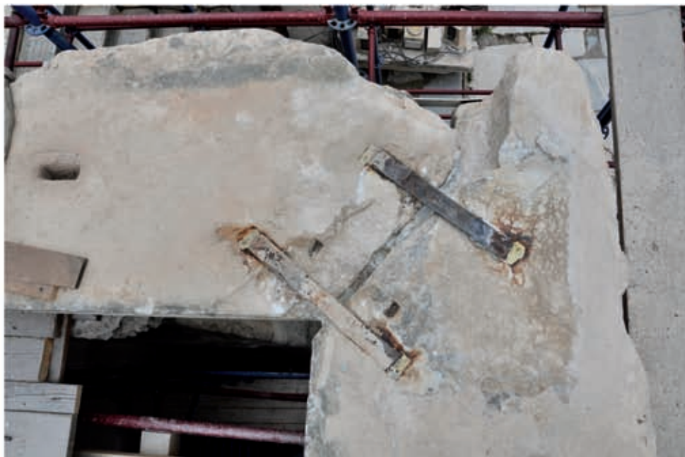
1 Verklammerung zwischen Architrav 040A und 089A an der Oberseite
