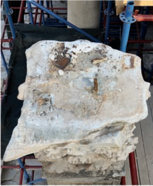
1 Oberseite des östlichen Pfeilerkapitells 025K mit sichtbaren Vertikaldübeln zu den darüberliegenden Architraven ( 040A. 089A )
