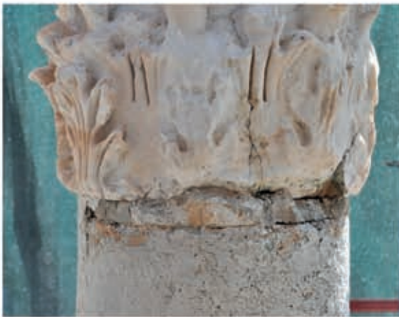
3 Vertikales Rissystem an der Nordseite von Kapitell 018K
