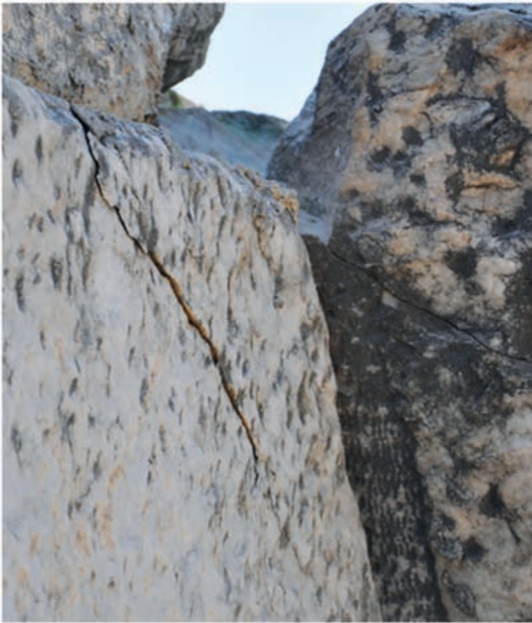
1 Schollenbildung an der Rückseite von Block 095L
