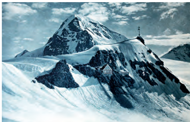
142. Hochalpine Forschungsstation Jungfrauojoch (3.457 m), Entwurf. Siglen: 1 Baustelle für das geplante Zentralgebäude; 2 Baustelle für den meteorologischen Pavillon auf dem Gipfel der Sphinx, 3.577 m; 3 Berghaus und Bergstation Jungfrauojoch der Jungfrauabahn
