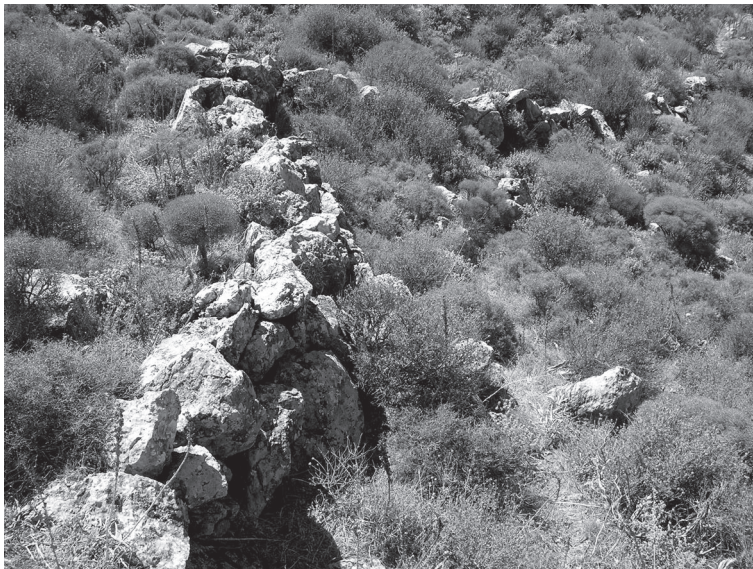
4 SITE 12: Aspro Nero. »Sperrmauer«. Draufsicht von Osten
