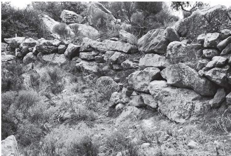
5 SITE 12A: Aspro Nero, [stou] Paletsi. Terras- senmauer mit »kyklopi- schen« Blöcken nördlich der »Nordbastion«. An- sicht von Nordwesten
