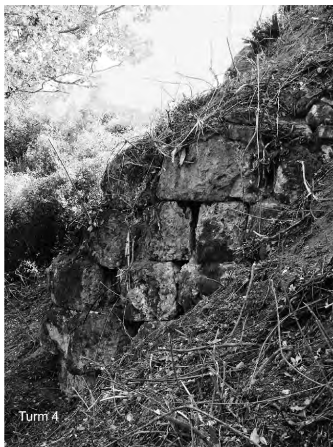
15 Turm 4 der Stadtmauer, von Westen
