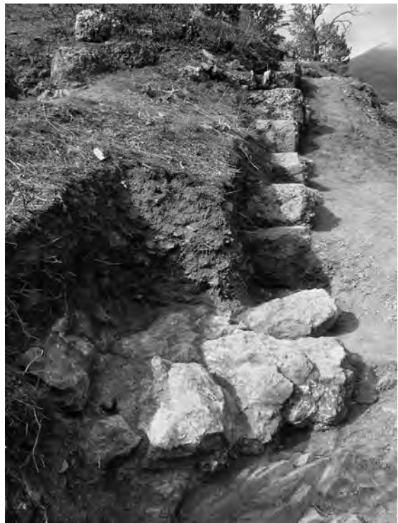
13 Östlicher ›Abschluss‹ der Stadtmauer
