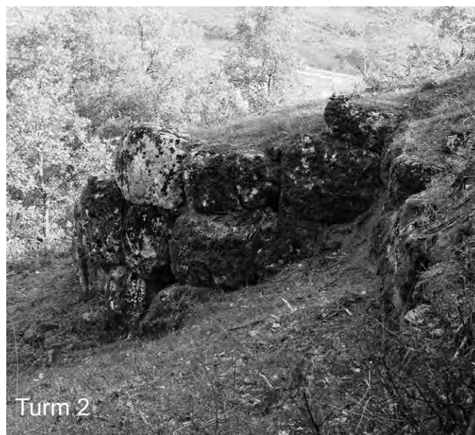
14 Turm 2 der Stadtmauer, von Westen
