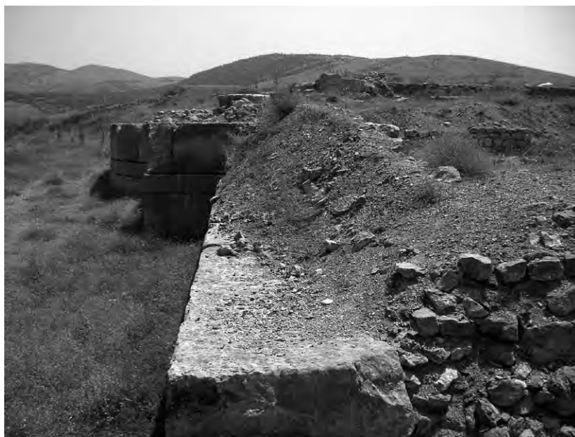
3 Abschnitt A, Badehaus mit rundturmartigen Vorsprung
