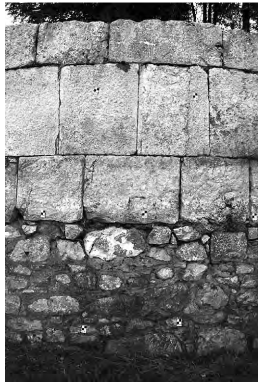
16 Abschnitt B, pseudoisodomes Mauerwerk des nördlichen Rundturmes mit Fundament aus opus caementitium
