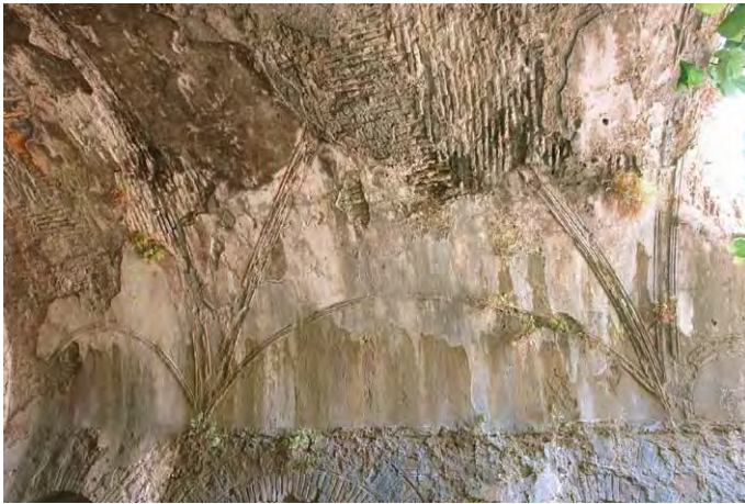
22 Stuckgewölbe des Bestattungssaals
